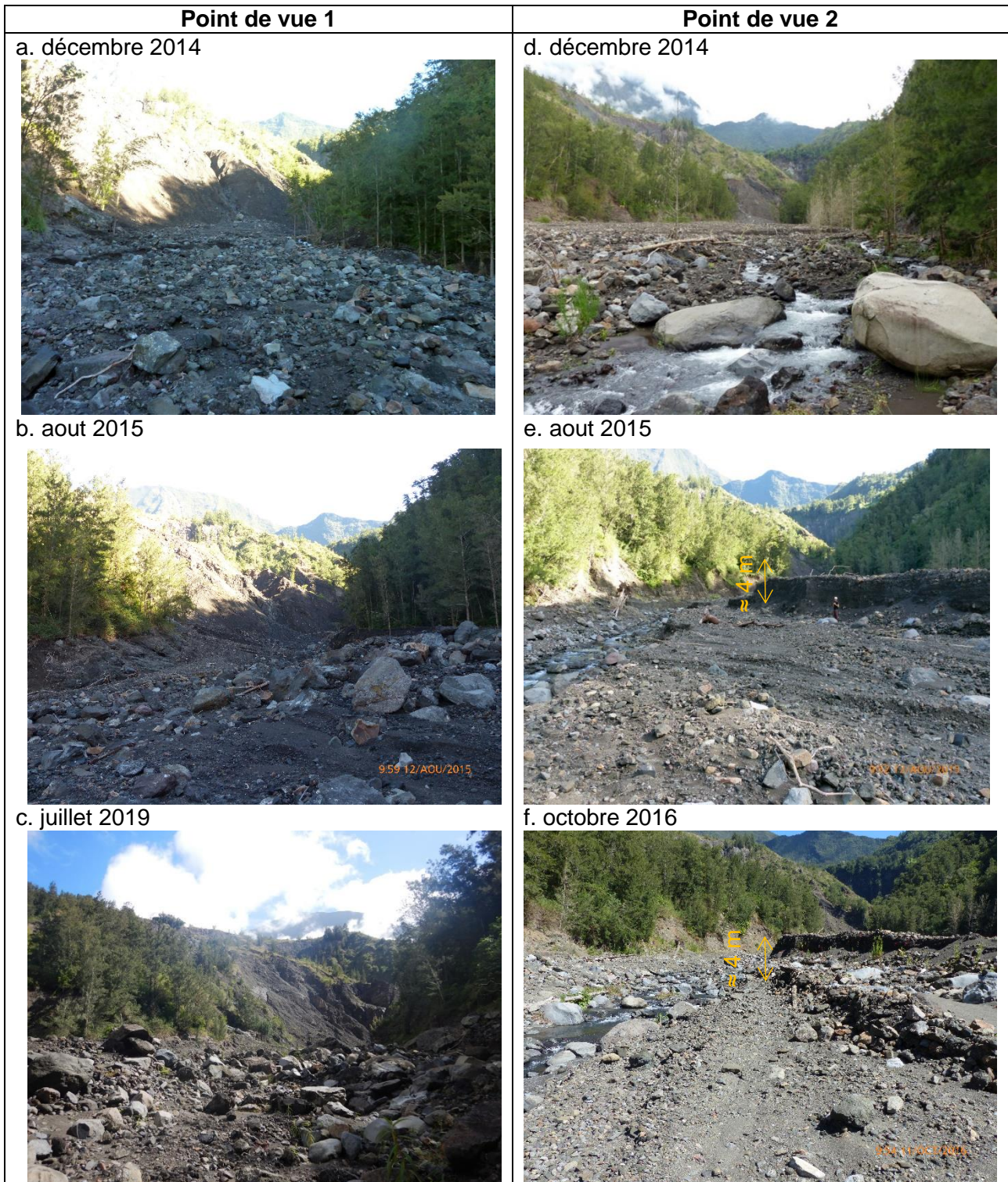
Figure 17 : Evolution du lit de la Ravine Roche à Jacquot en aval du glissement principal, en deux points localisés sur la Figure 16, entre décembre 2014 et juillet 2019 (point de vue 1) et octobre 2016 (point de vue 2).
