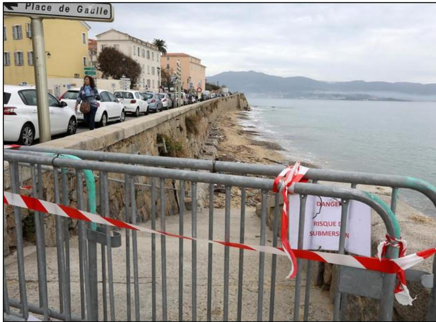
*Illustration 52 : Érosion de la plage Saint-François avec dégradation du mur de soutènement de la voie littorale (affouillement, photo Corse matin, 03/11/2018).*
