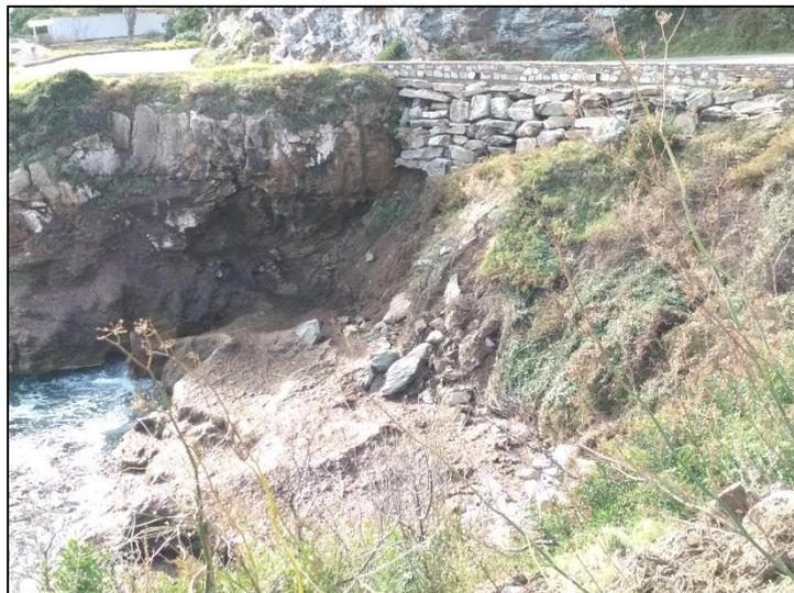
*Illustration 16 : Traces d'érosion marine sous l'ouvrage de soutènement de la route D80 sur la commune de Sisco (BRGM, 07/11/2019).*
