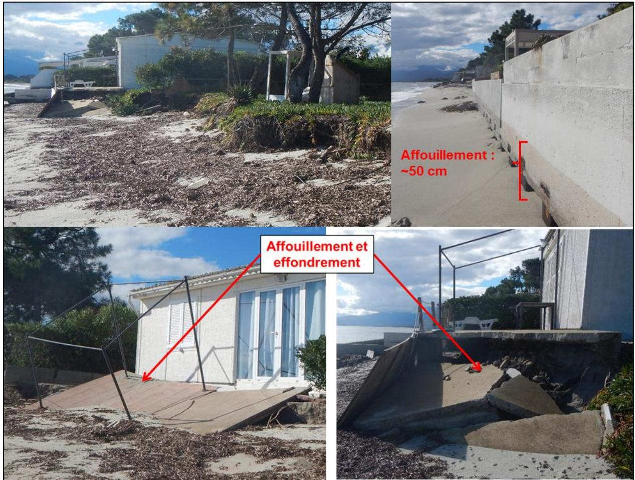
Illustration 42 : Plage d'Erba Rossa, érosion du front dunaire a), affouillement et dégradation d'ouvrages b), c) et d) (BRGM, 07/11/2018).
