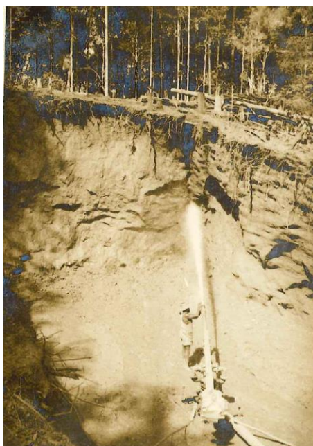
Fig. 3 – Recherche de pegmatites par monitor à Belle-Étoile (BRGM, 1958)
