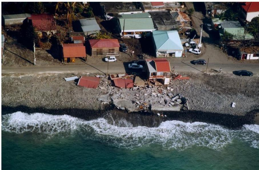
Illustration 5 – Exemple de l’impact du choc mécanique des vagues sur le littoral de la Basse-Terre suite au passage de l’ouragan Lenny (BRGM, 1999)
