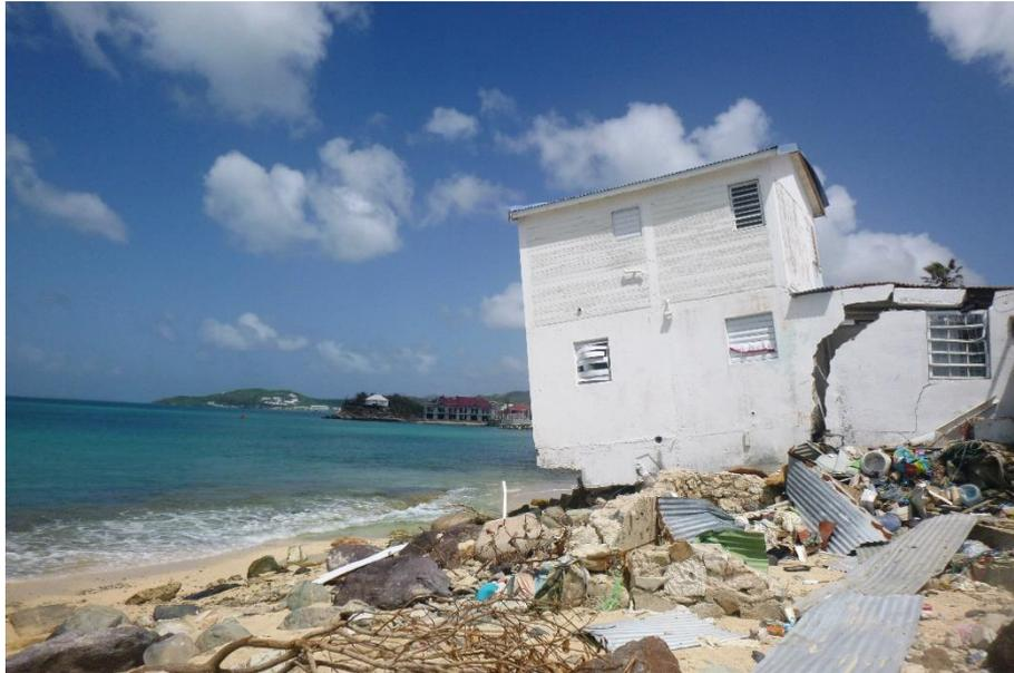
*Illustration 7 : Déstabilisation d'un bâtiment par affouillement de ses fondations induite par l'érosion littorale à Sandy Ground (Saint-Martin) après le passage d'IRMA (BRGM, 2017).*
