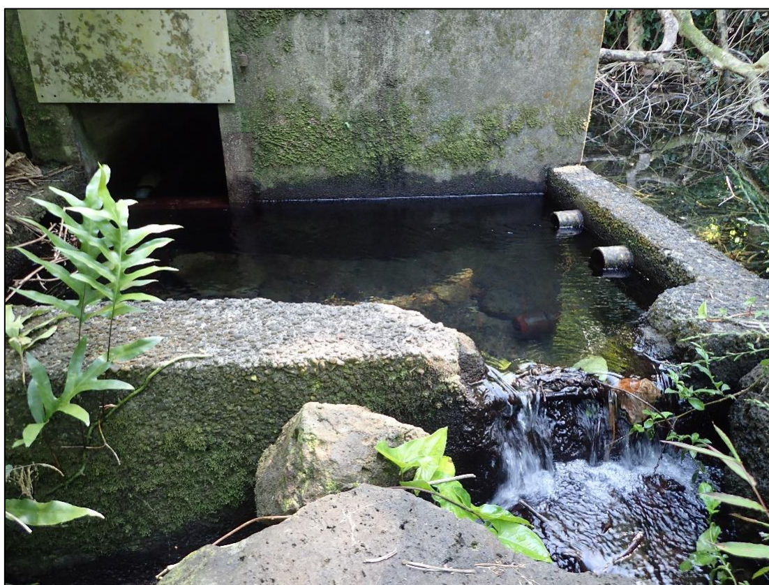
Illustration 16 - Regard de captage de la source Vaiava à Afareaitu, île de Moorea (source BRGM).
