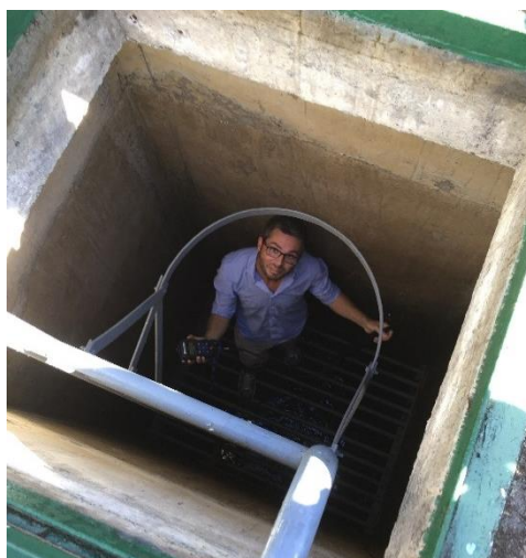
Illustration 18 - Réalisation de mesures physico-chimiques dans le regard d'une galerie drainante à Pirae (source : BRGM)
