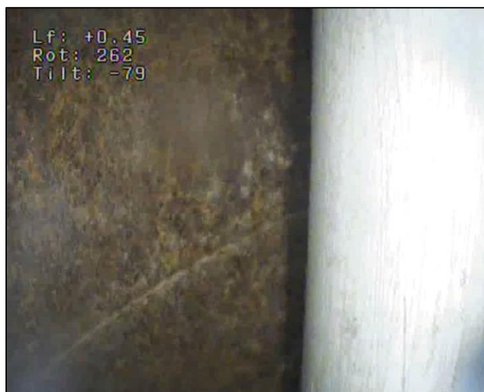
Illustration 13 - Photographie prise lors d'une inspection caméra (source : BRGM).
