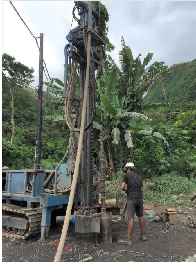
Illustration 5 - Exemple de foration au marteau fond de trou à Paea - Tahiti (2018) (source : BRGM).
