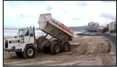
Le transport mécanique terrestre comprend notamment **les travaux de reprofilage ou encore de nivellement**, propres au transfert intracellulaire.
