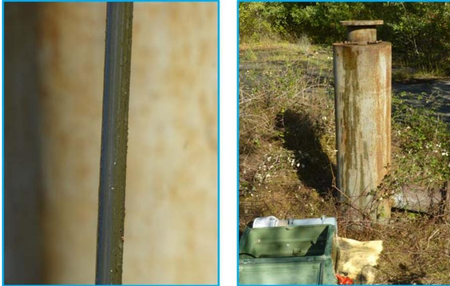
Figure 24 : Etat du bitube (à gauche) et de la tête de forage (à droite) à l'issue de la remontée du préleveur de fon, dans le forage de Lacquy.
