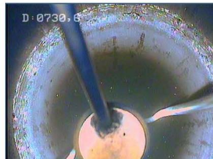
Paroi uniforme propre - Raccord entre tubes légèrement marqué par des dépôts
