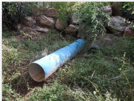
*Figure 74 : Exemple de connexion hydraulique reliant une zone basse à la mer (commune de Porto-Vecchio, cadre rouge : localisation de la buse sous la route).*
