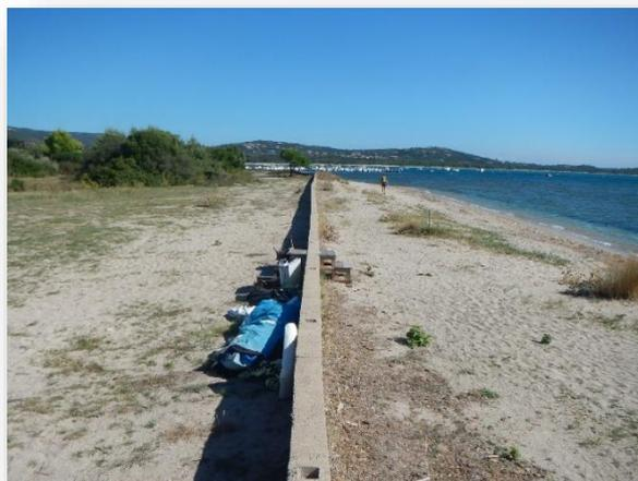
Figure 73 : Exemple d’ouvrage (muret) ayant potentiellement un rôle sur l’écoulement de l’eau en cas de submersion marine (commune de Lecci, San Ciprianu).
