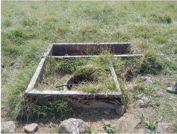
Domaine de Quatre Paysans : abreuvoir rectangulaire bétonné, et coffrage carré bétonné abritant une buse protégeant la tête de forage
