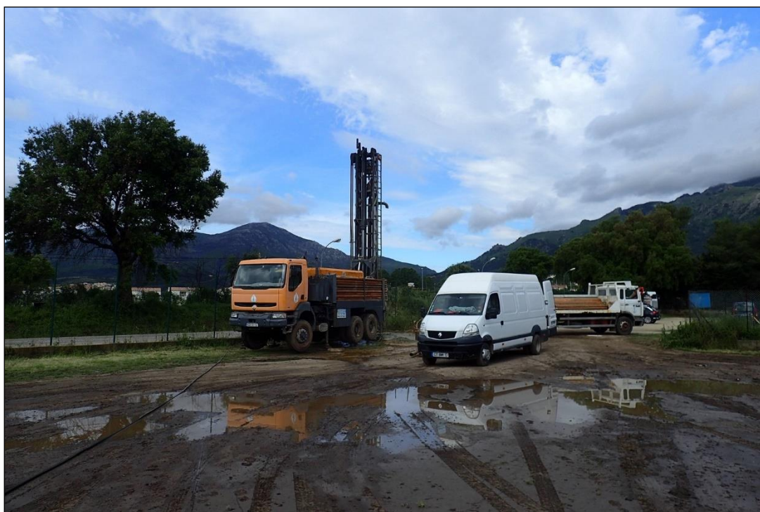
Illustration 5 : Chantier de foration de Pz3.
