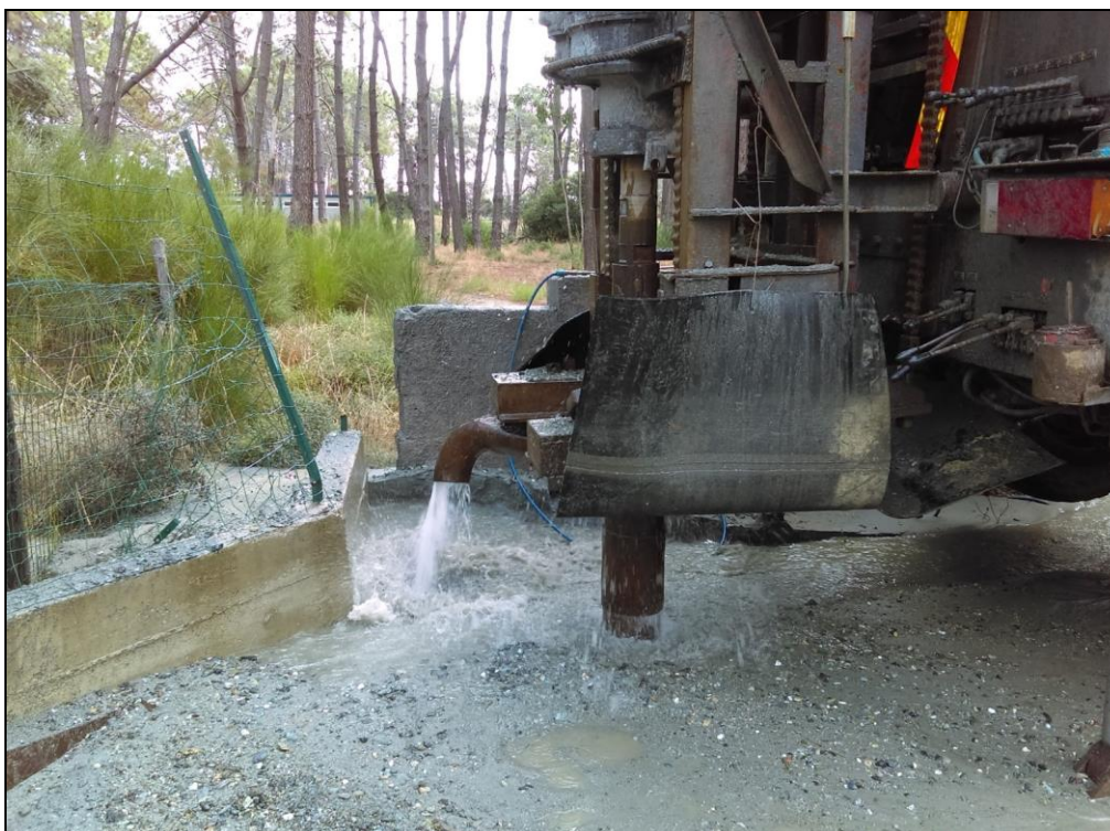
Illustration 38 : Soufflage à la fin d'un tube, dans la partie aquifère de Pz4.
