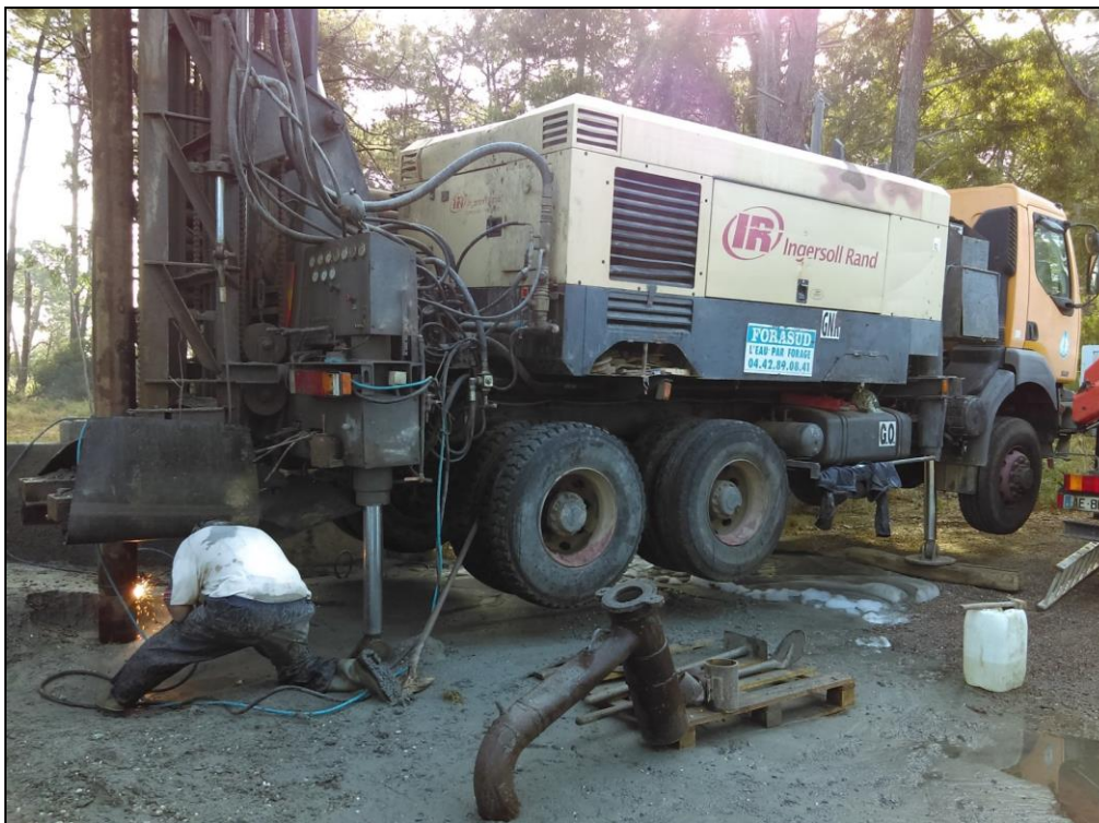
Illustration 37 : Soudure de deux tubes acier de soutènement pendant la foration de Pz4.
