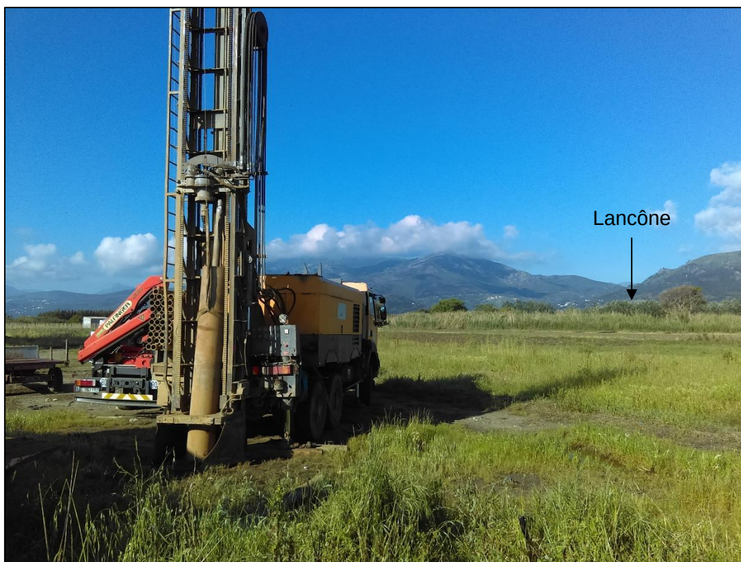
Illustration 12 : Chantier de foration de Pz5.
