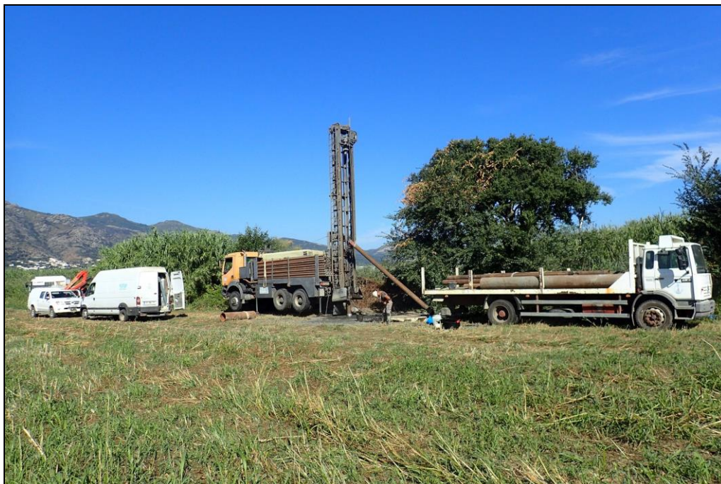
Illustration 29 : Phase de foration en petit diamètre sur Pz2.
