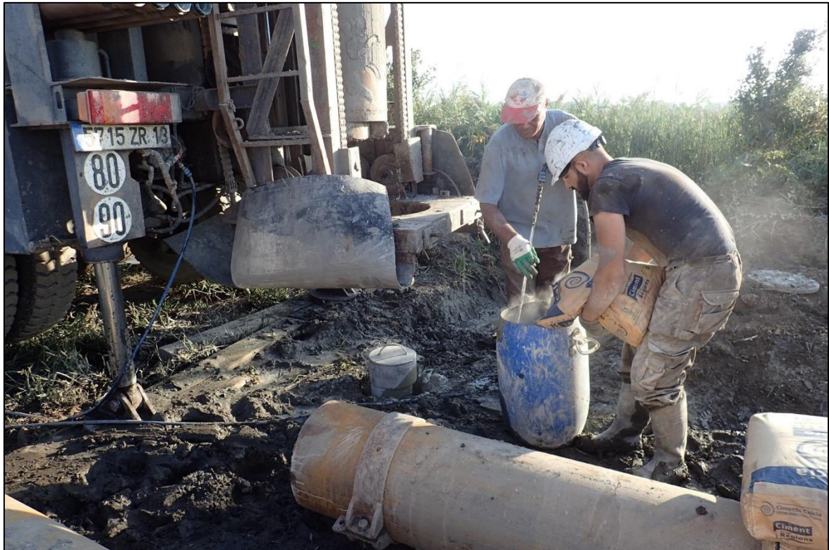
Illustration 20 : Cimentation de l'espace annulaire de la portion forée en 425 mm sur Pz1.
