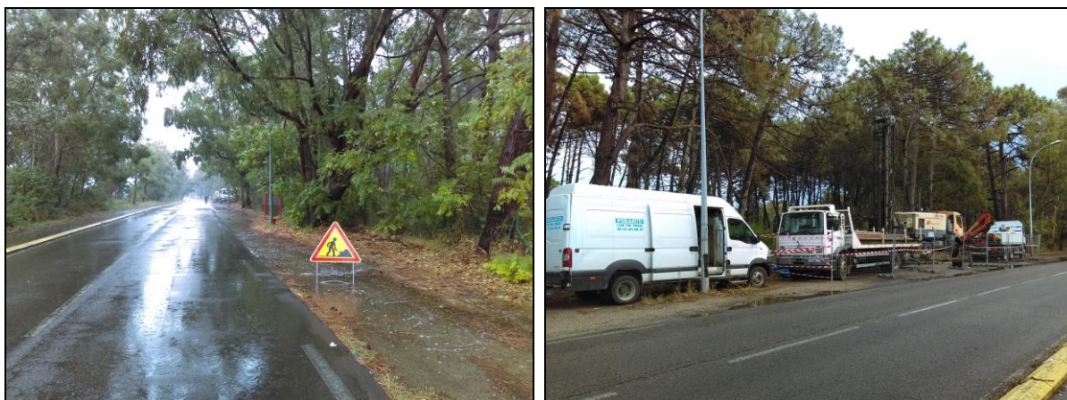
Illustration 35 : Signalisation du chantier de Pz4.
