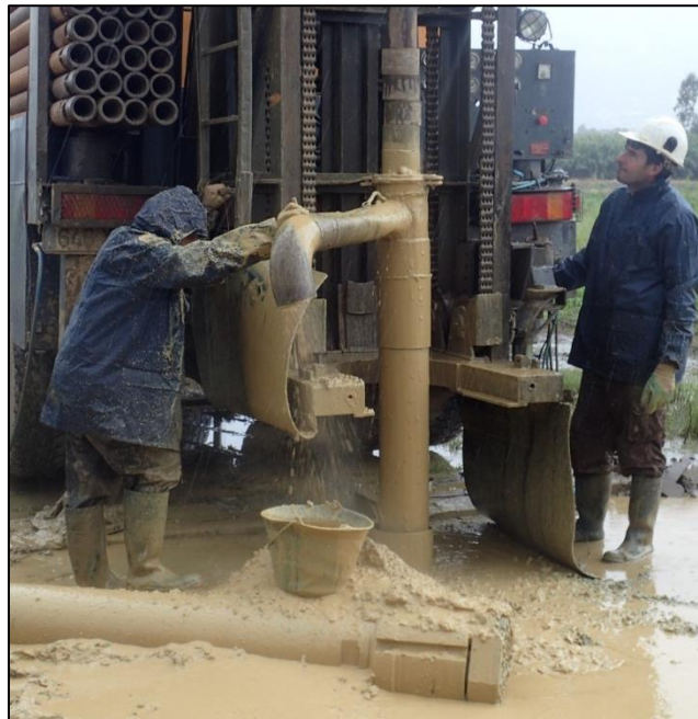
Illustration 14 : Photographies de la phase de foration de Pz5.
