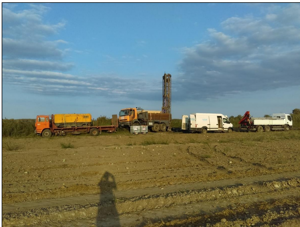
Illustration 18 : Chantier de foration de Pz1.
