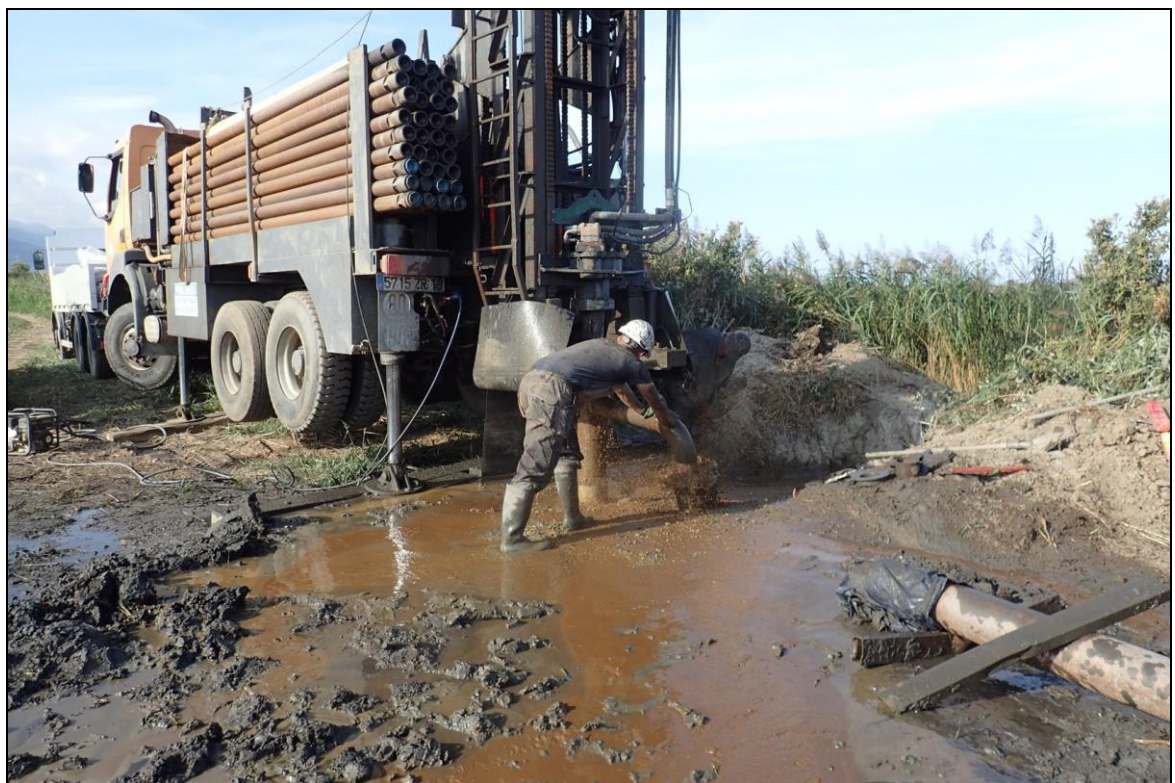
Illustration 21 : Foration en petit diamètre de Pz1, profondeur atteinte d'environ 18,50 m.
