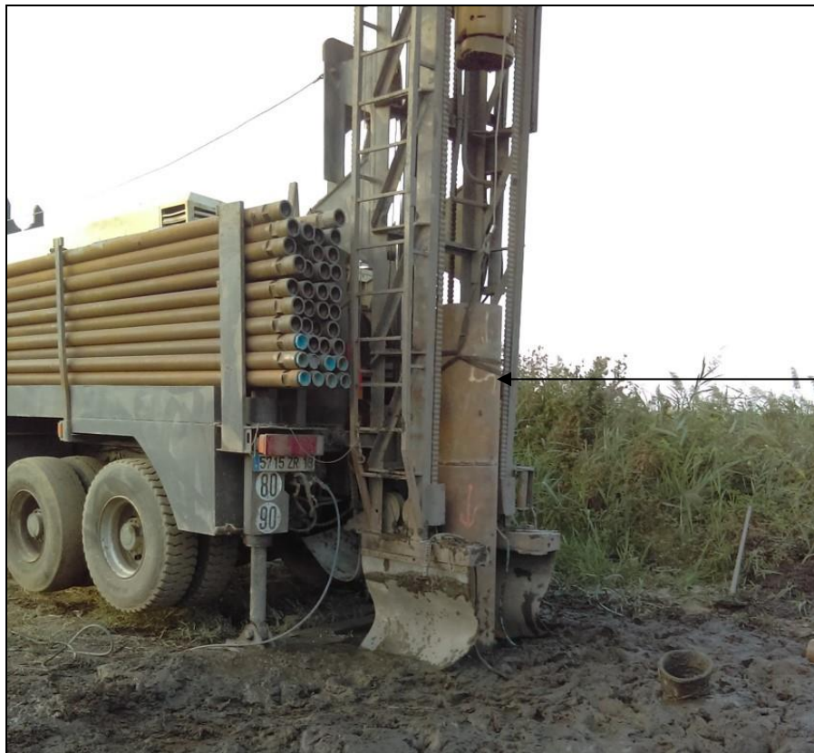
Bout de tube rajouté avant départ du chantier
