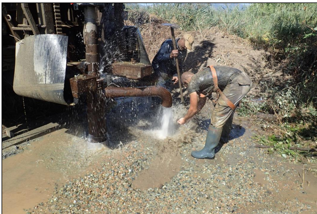
Illustration 30 : Soufflage dans le tube à la fin de la foration de Pz2.
