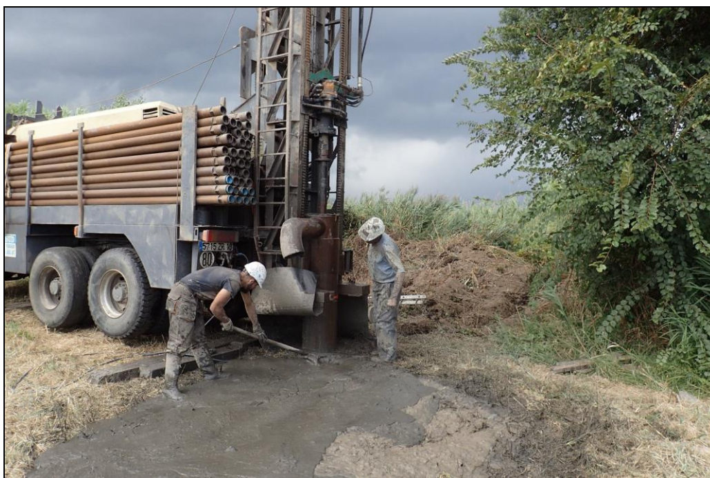
Illustration 28 : Foration en gros diamètre des limons sur Pz2.
