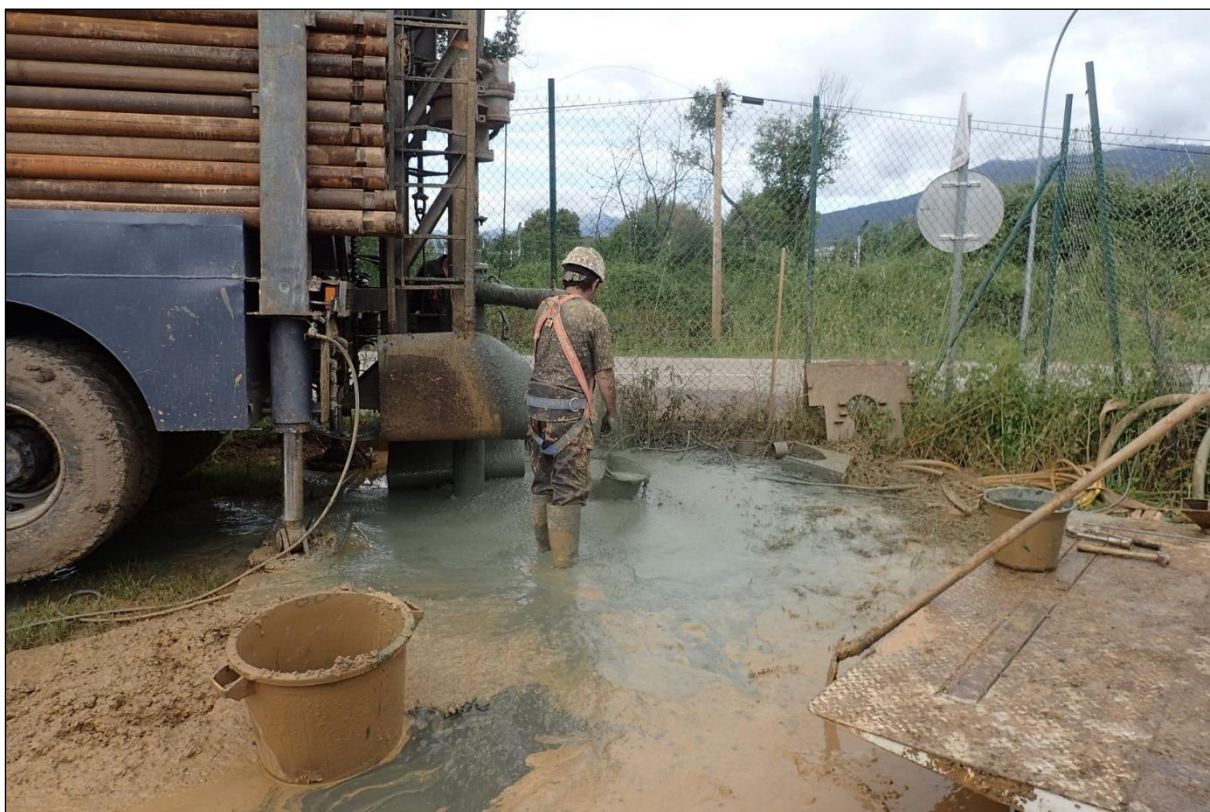
Illustration 7 : Changement de couleur des cuttings avec apparition d'un niveau d'argile couleur verdâtre au cours de la foration de Pz3.
