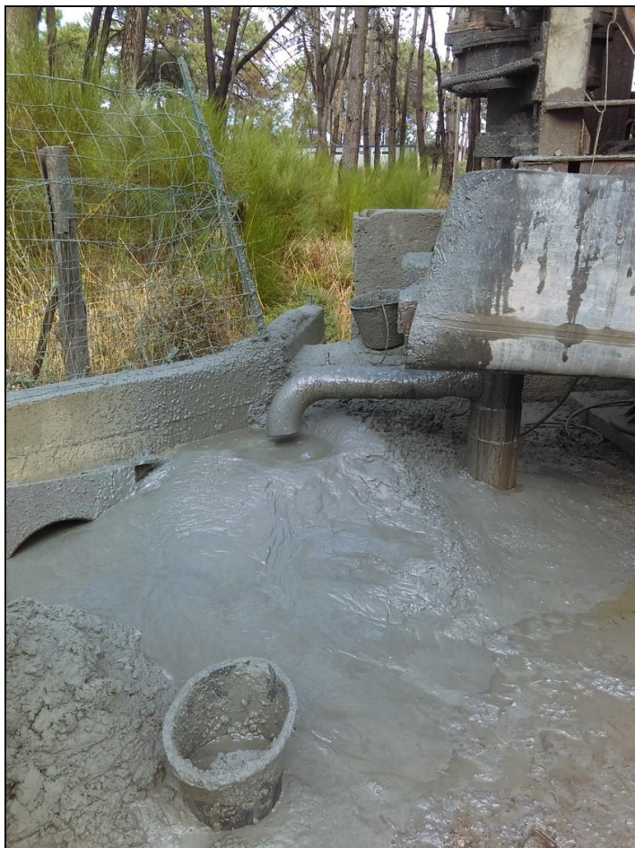
Illustration 36 : Foration dans le sable fin gris de Pz4.
