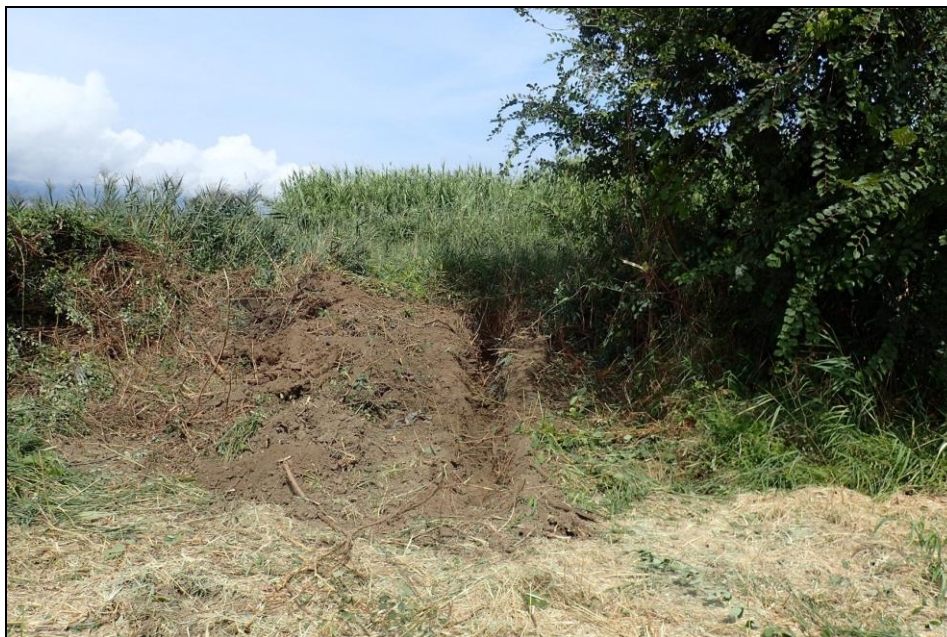
Illustration 27 : Tranchée creusée au niveau du futur emplacement de Pz2 pour évacuer les eaux vers le Fossé de Borgogna.
