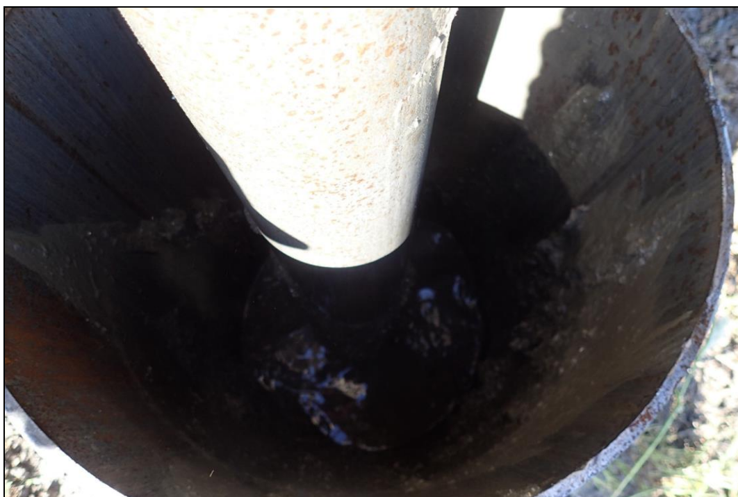
Illustration 13 : Remontée des limons vaseux dans le tube acier sur Pz5 à la fin du premier tube de 3 m.
