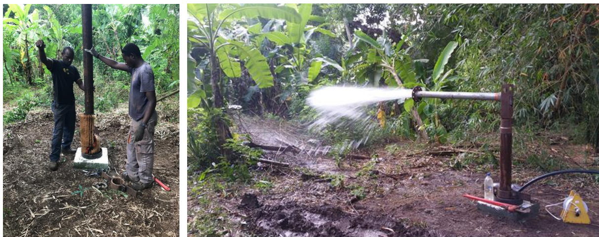
Illustration 74 : Opérations de brossage et d'air-lift dans le forage de Bandrélé-Dagoni.
