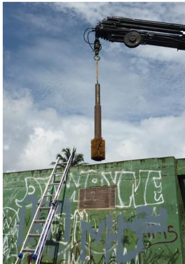
Illustration 73 : Opération de brossage dans le forage de Kawéni 2 (à droite).
