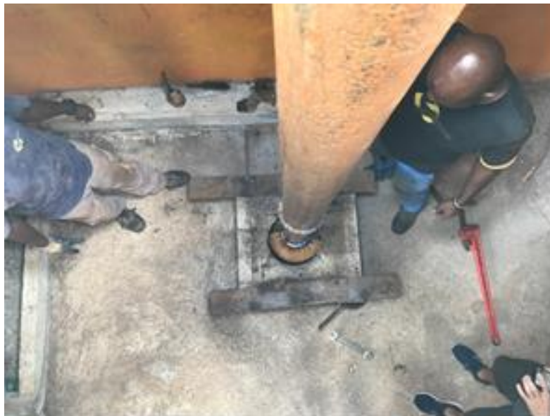
Illustration 75 : Opération de brossage dans le forage de Mréréni 2.
