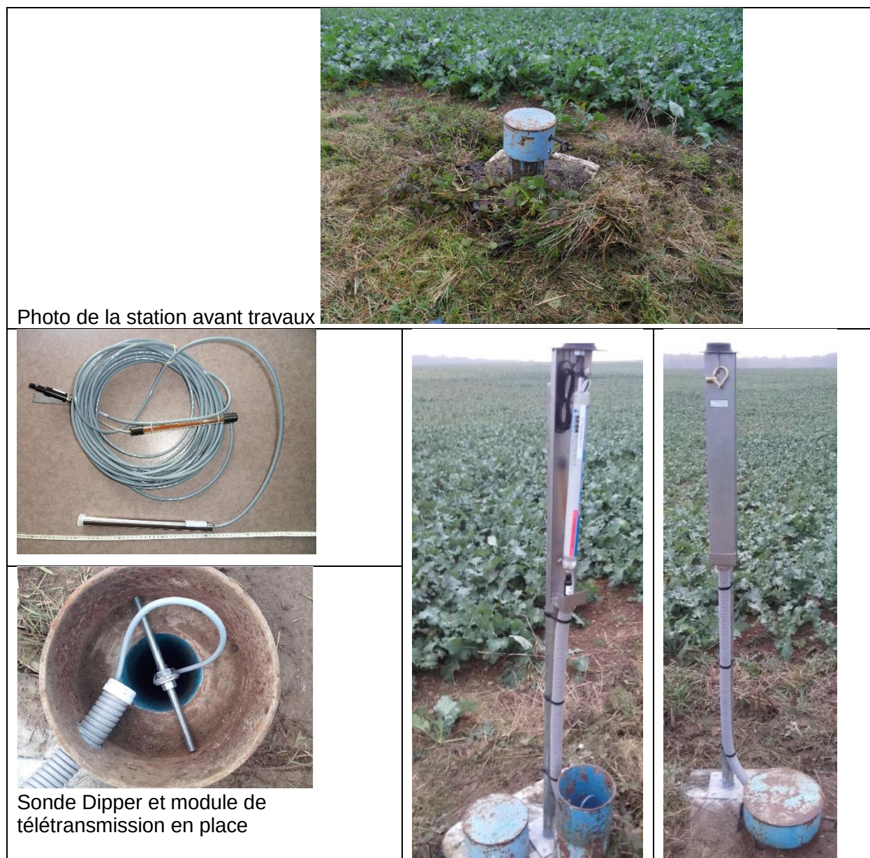
Illustration 8 : Photographie avant et après aménagement des stations C11e t C12
