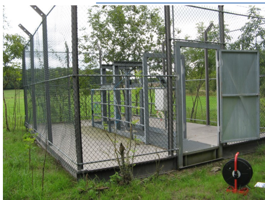
Puits Cheminée sud à Boulange (N5)
