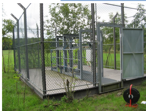
Puits Cheminée sud à Boulange (N5)
