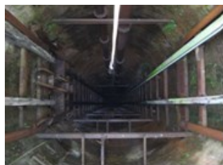
Puits de Bure
