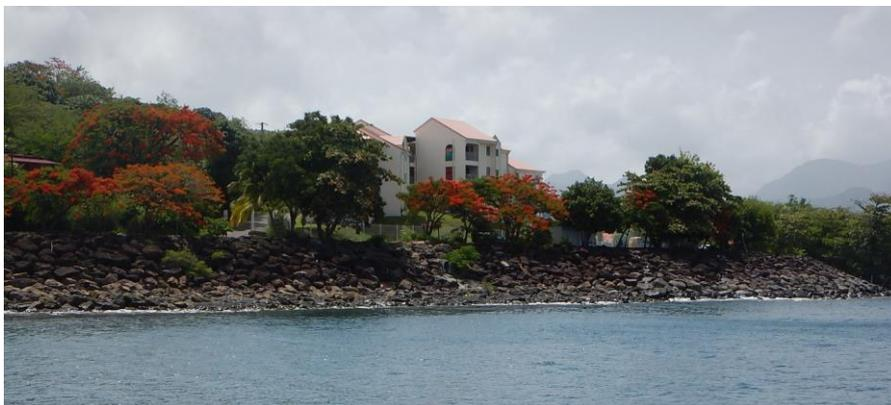
*Illustration 61 : Enrochement de protection mis en place sur une hauteur et une largeur conséquente. Pointe Lamarre*
