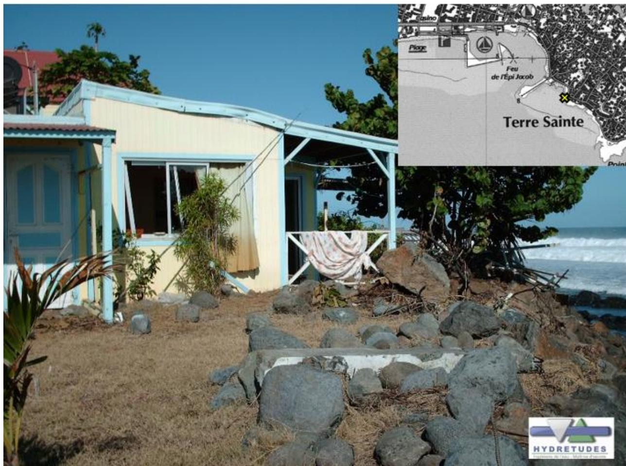
Figure 4 : Photographie des impacts sur le littoral de Terre Sainte suite aux houles australes de mai 2007 : enrochements projetés sur la parcelle (Hydretude, 2007<sup>24</sup>)
