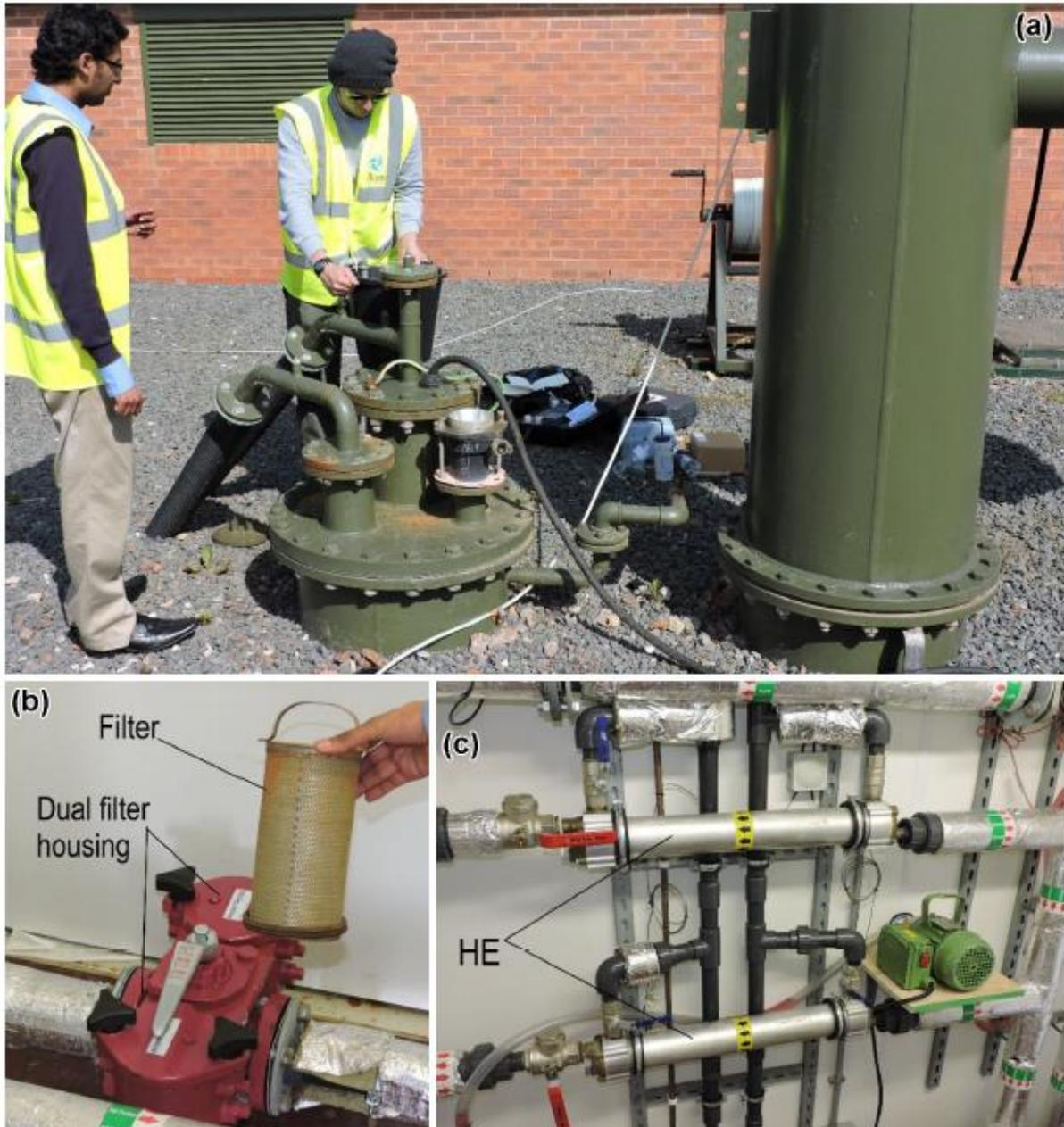
Figure 17 : (a) Tête du puits n° 3, (b) filtres en amont des échangeurs et (c) échangeurs de chaleur tubulaires (source : Banks et al., 2016).
