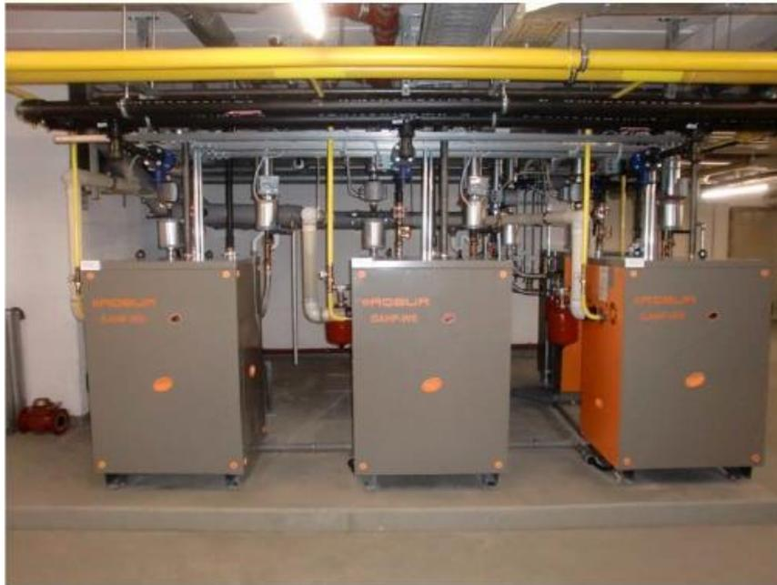
Figure 6 : Système de pompe à chaleur utilisé (Thien, 2015).
