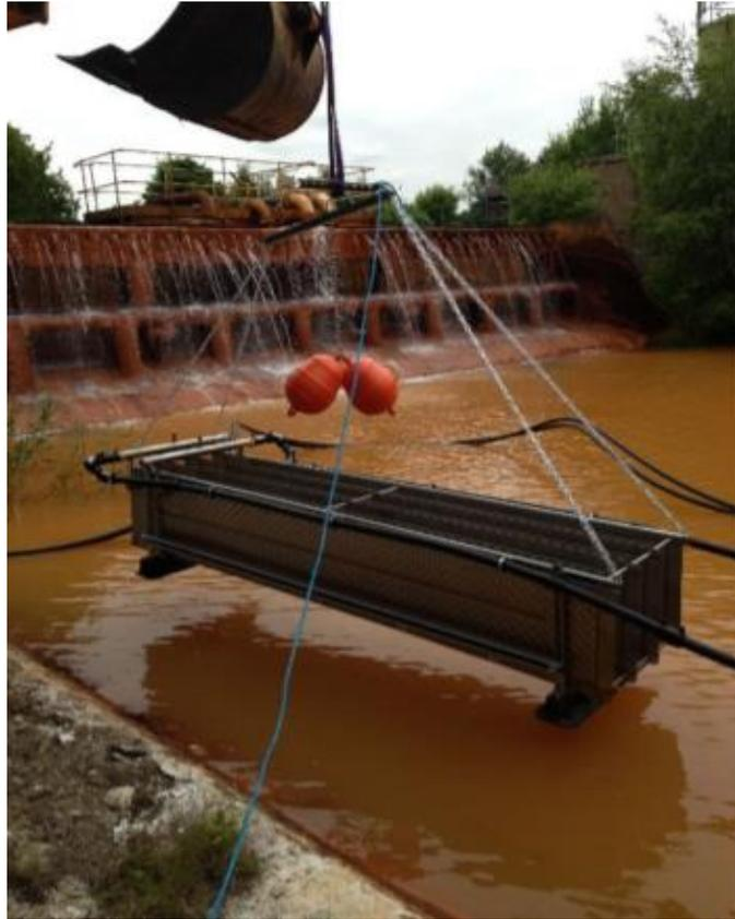
Figure 19 : Système de récupération de la chaleur lors de sa mise en place dans le premier bassin d'aération de traitement des eaux de la mine (source : Banks et al., 2016).
