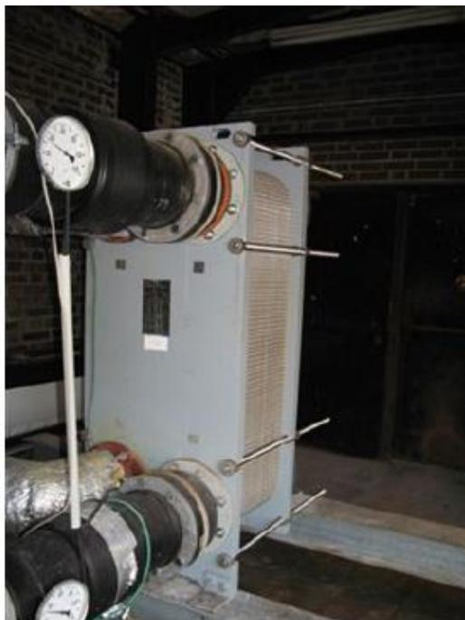
Figure 4 : Échangeur de chaleur utilisé (source : Thien, 2015).
