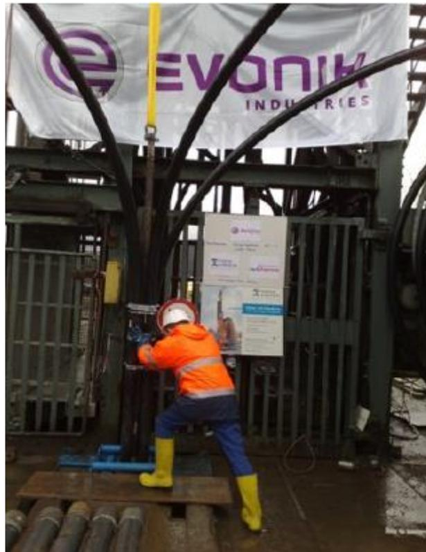
*Figure 5 : Mise en place de la sonde en « double-U » au puits d'Auguste Victoria (source : Thien, 2015).*
