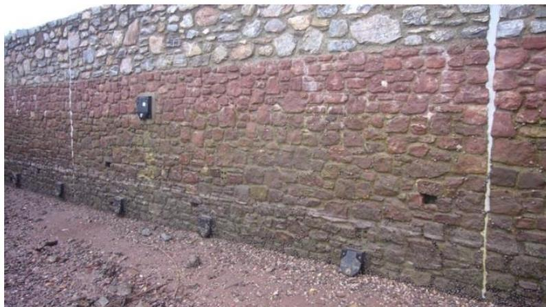
Figure 25 : Clapets anti-retour sur buse d'évacuation d'eau en cas de submersion à Shaldon (UK).
