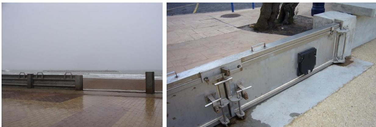
Figure 12 : Gauche : Batardeau en cours d'installation, Valras-Plage (2006). Photo Manuel Garcin.
