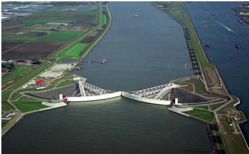
Figure 14 : Barrage « Maeslantkering » en position fermée en aval du port de Rotterdam (Pays Bas) (source Rijkswaterstaat)
