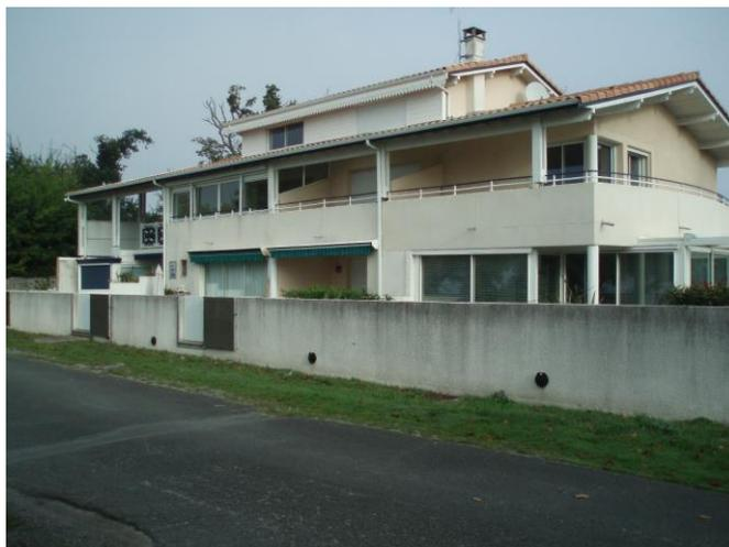
Figure 20 : Porte étanche, muret et clapets anti-retour facilitant l'évacuation de l'eau (Andernos, 33).
