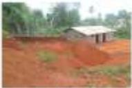
La construction d'une maison sur des pentes souvent fortes conduit à des travaux de terrassement, avec un déblai sur une partie de la parcelle, et un remblai sur l'autre partie. Les surplus de terre sont évacués dans les pentes au sud des tas de terre. Ces travaux conduisent à des stocks de terre qui peuvent être exportés lors des pluies. Il existe des techniques pour limiter cela (en photo après) :
