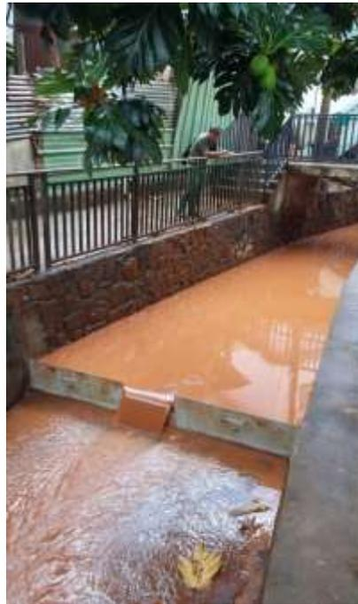
MTS aval - Seuil de jaugeage (en haut, schéma vue de face, depuis l'aval, en bas Photo : Vue aval, rive gauche
