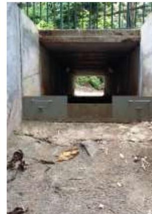
*MTS amont - Seuil de jaugeage (à gauche, schéma vue de face, depuis l'aval, à droite Photo : Vue aval)*
