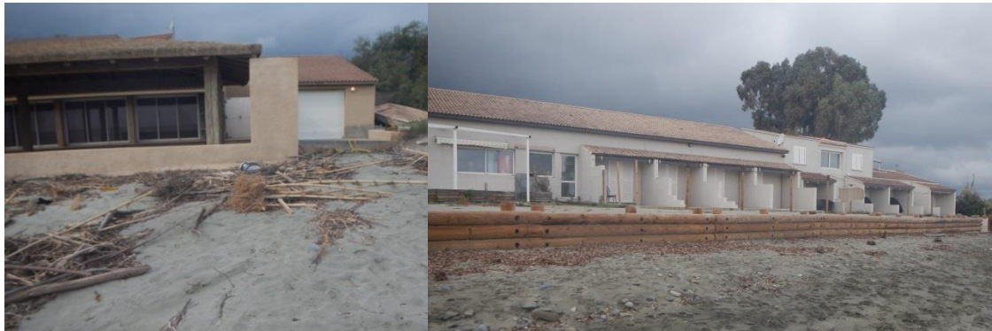
Illustration 5 – Présence d'enjeux plus ou moins proches du rivage sur Campoloro Nord (ROL/BRGM,26/10/2015).
