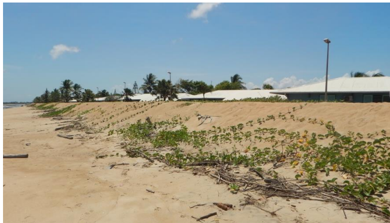
Illustration 34: Cordon de protection artificiel avec revégétalisation de celle-ci, octobre 2016
