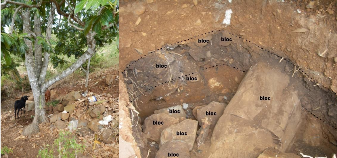
Figure 10 – Dépôts torrentiels de conglomérats lités observé en amont du glissement (à gauche) et en aval du glissement (à droite)
