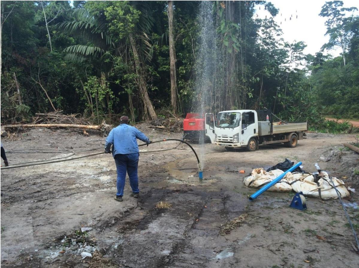
*Illustration 15 : Insertion du tube PE dans le sondage SR2 (BRGM)*
