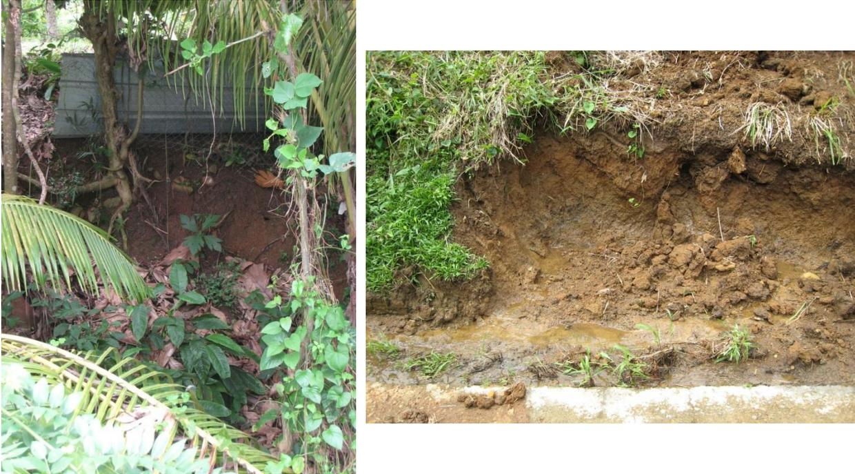
Illustration 8- Exemple d'observations réalisées en 2016. Photographie de gauche : instabilités superficielles le long du ruisseau de Morne-Figue. Photographie de droite : altération des basaltes de Vert-Pré pouvant être localement destabilisés de manière superficielle.
