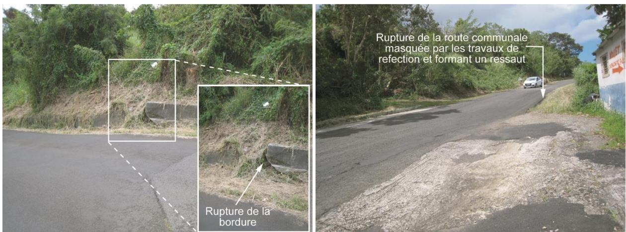
Illustration 10 - Indices d'instabilité sur la Route communale de Morne-Figue en 2016. A gauche rupture de la bordure en béton. A droite ressaut sur la route en limite du glissement (Fond SCAN 25®, Orthophoto 2010 IGN®, Relief dérivé du MNT Litto 3D).
