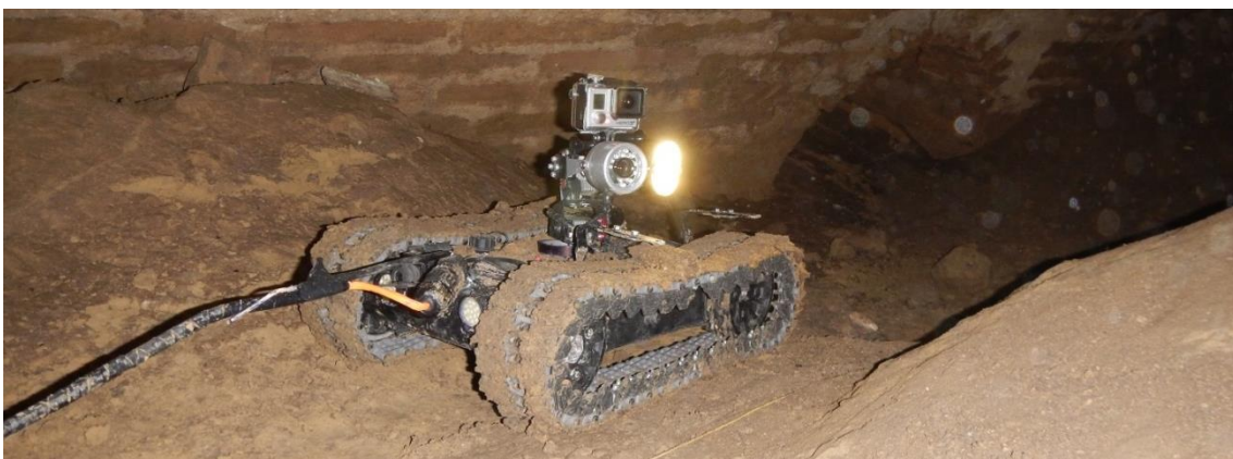
Illustration 1 : Photographie du robot Magellan de la société CAMEXPLO utilisé lors de l'inspection de la galerie G1
