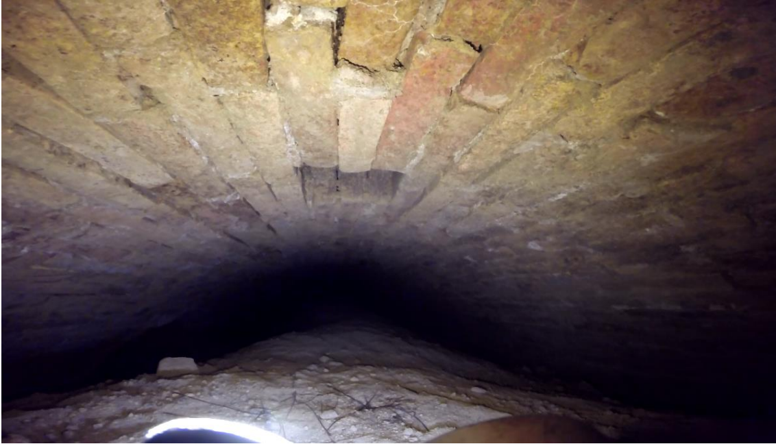
Illustration 2 : Taux de remplissage de la galerie G1 du réseau ST009 – Capture d'écran de l'inspection vidéoscopique
