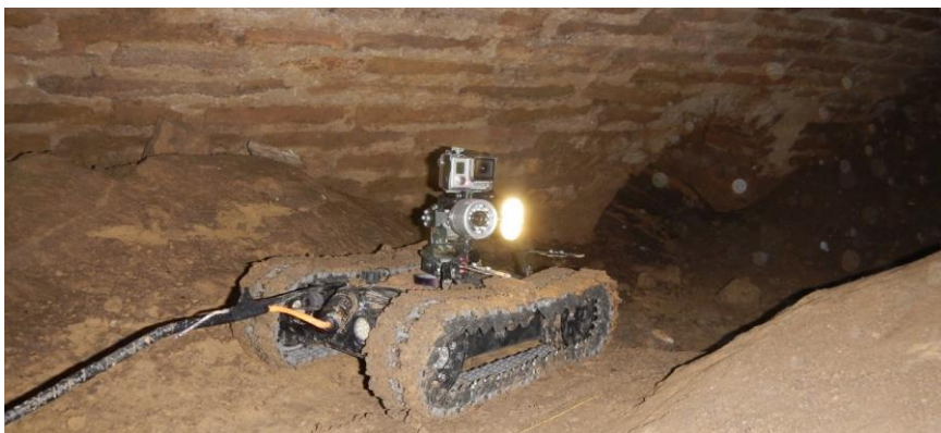
Illustration 10 : Outil robotique utilisé dans le cadre de l'inspection de la galerie G1 du réseau de la rue Lothaire (ST009)
