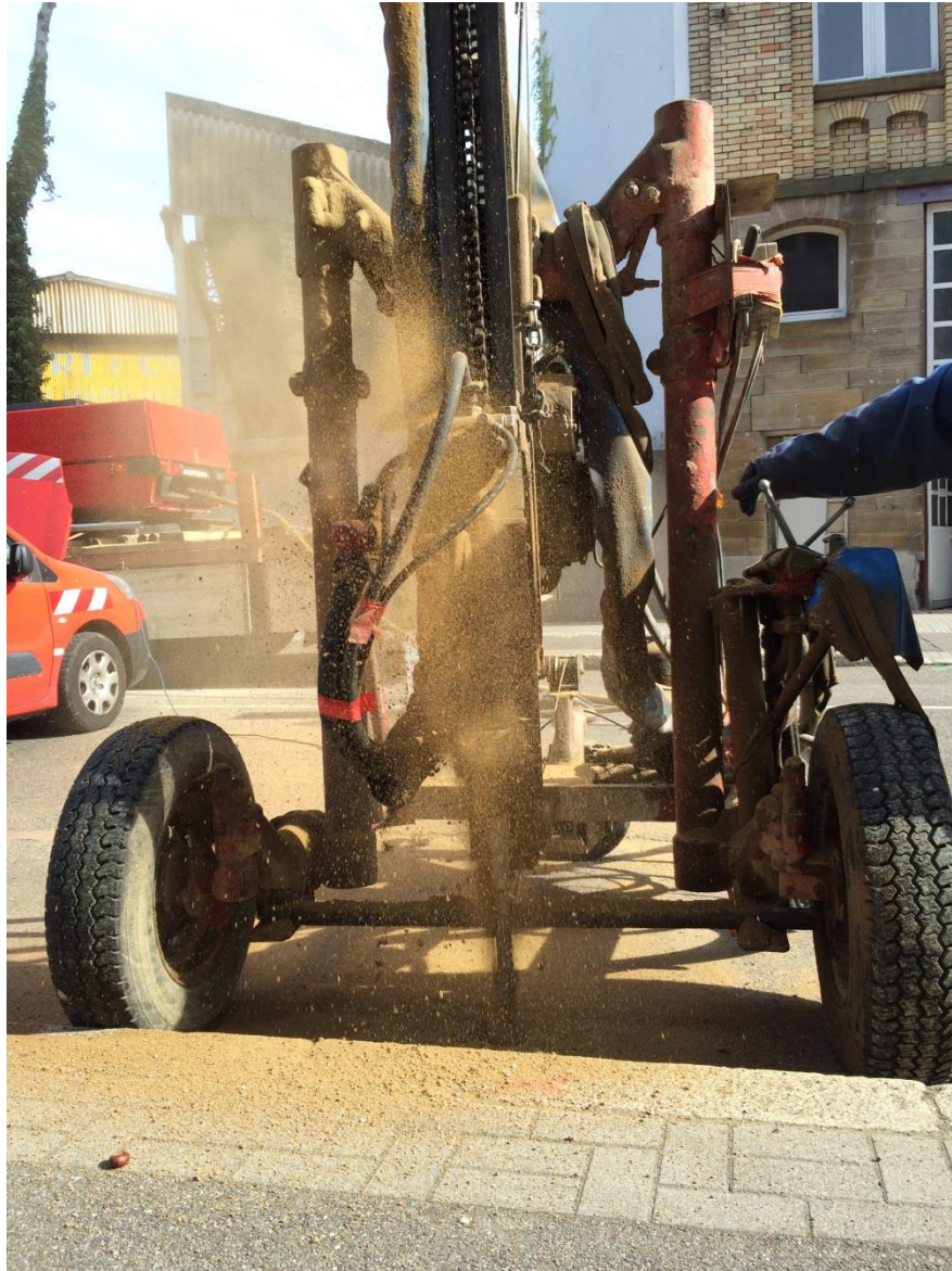
Illustration 9 : Opération de forage suite aux investigations géophysiques réalisées route de Bischwiller à Schiltigheim
