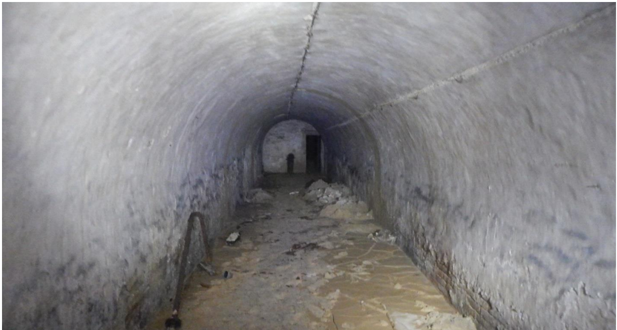
Illustration 7 : Photographie d'une galerie du réseau de galeries souterraines Alsia SC008
