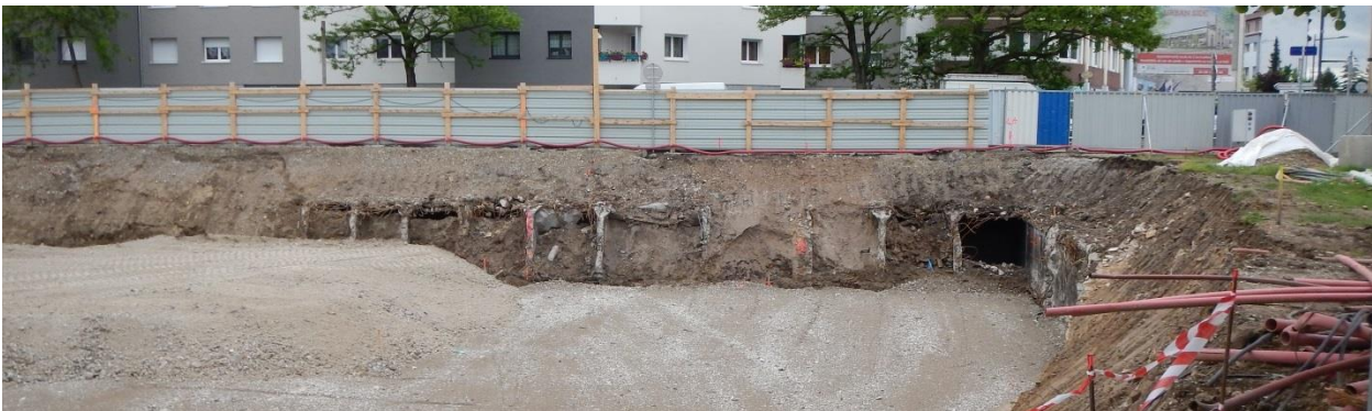
Illustration 6 : Reliquat des galeries souterraines de l'ancienne brasserie Perle après travaux de décaissement lors des travaux de réhabilitation
