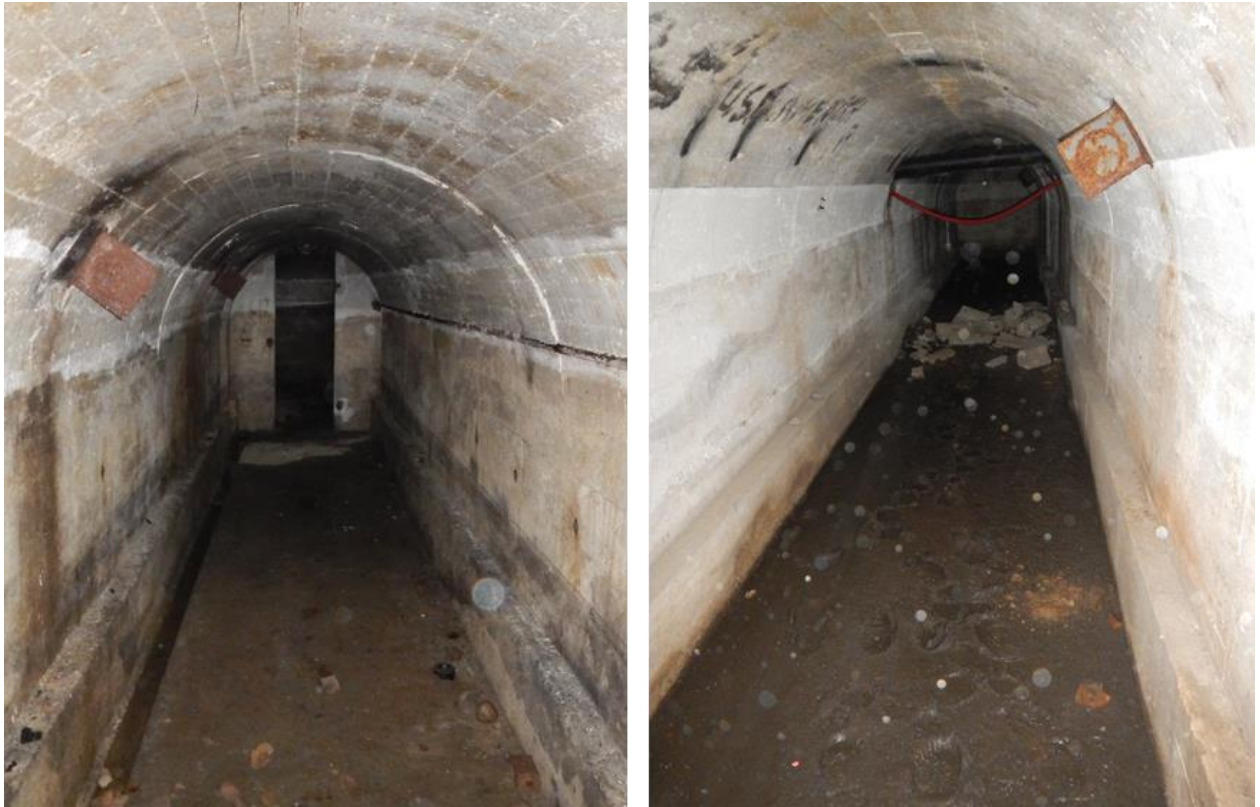
Illustration 3 : Galeries de type « abri de défense passive » (à gauche ST266, à droite HO010)
