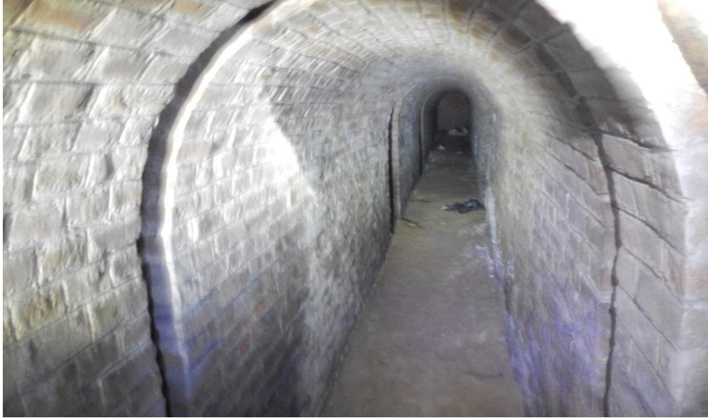
Illustration 2 : Galerie militaire de type « contre-mine ou d'écoute » (Réseau RE001 – Fort Rapp)
