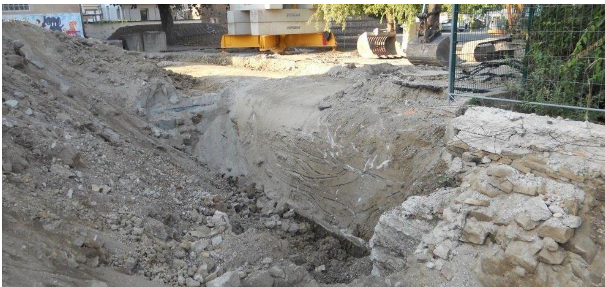
Illustration 4 : Abri-tranchée excavé rue de l'Ecole à Hoenheim
