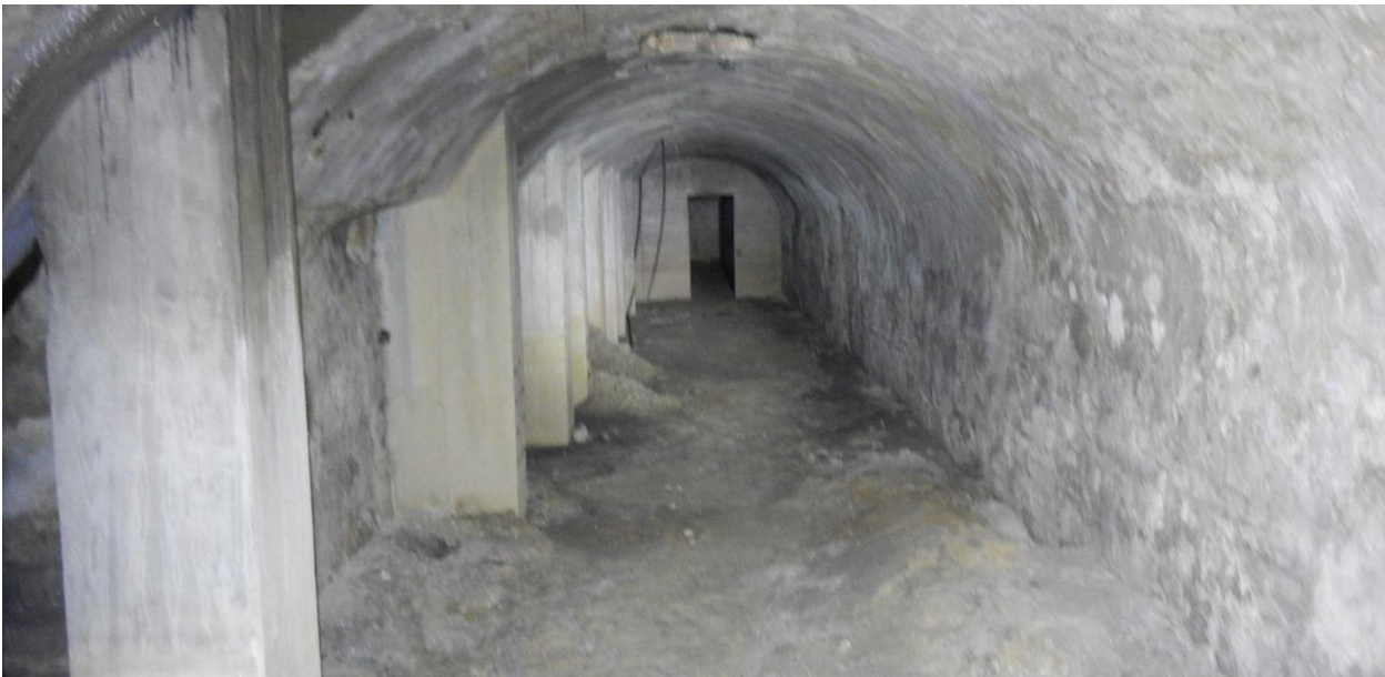
Illustration 5 : Photographie d'une galerie souterraine du réseau de la rue de Dachstein (SC002)
