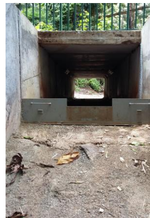
Illustration 4 : MTS amont - Seuil de jaugeage (à gauche, schéma vue de face, depuis l'aval, à droite Photo : Vue aval)
