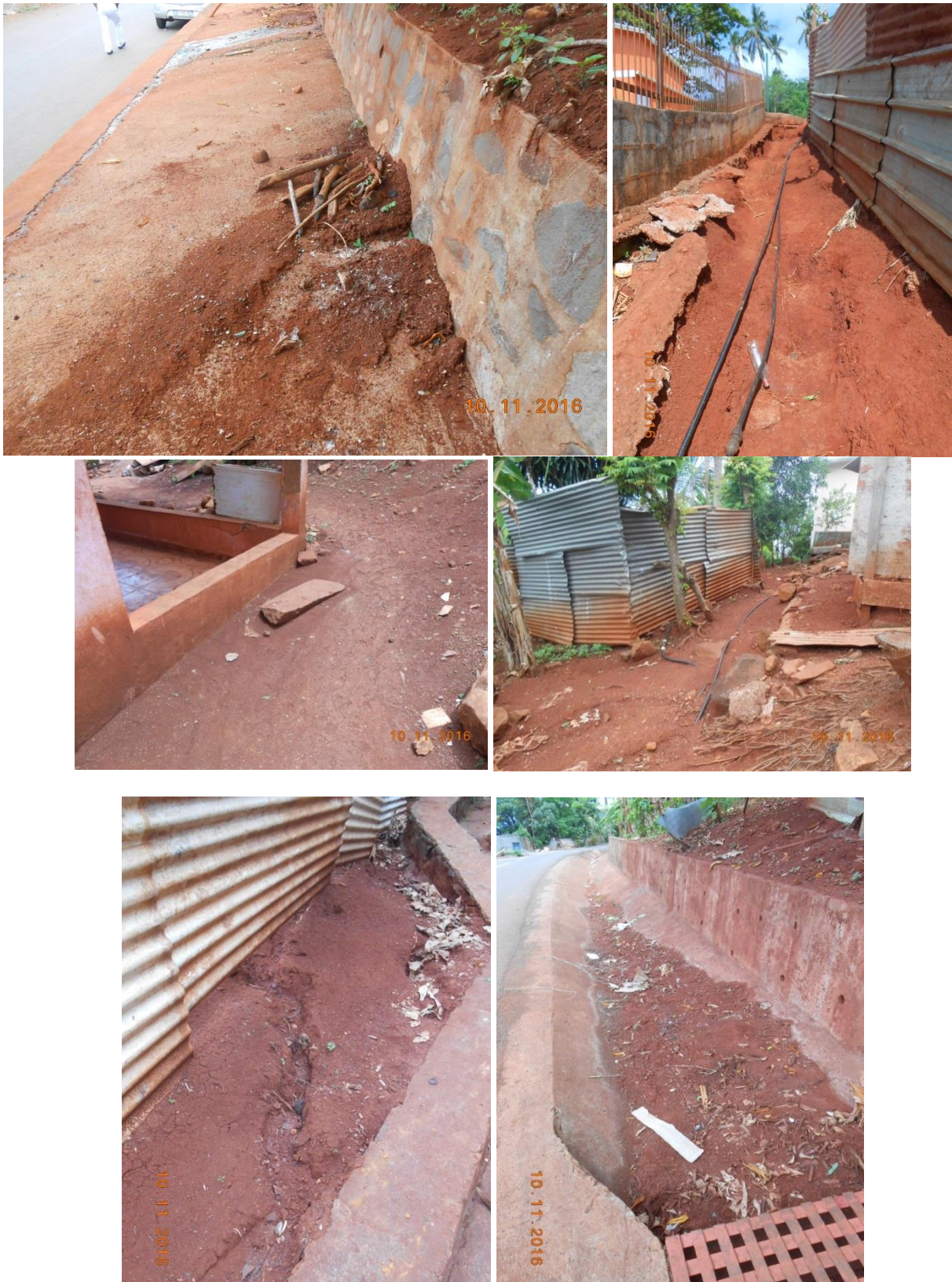
Illustration 22 : Ravinement localisé avec concentration des écoulements
