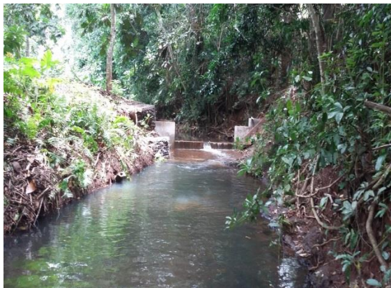
(a) Seuil de Mro Oua Bandrani (vue aval)
