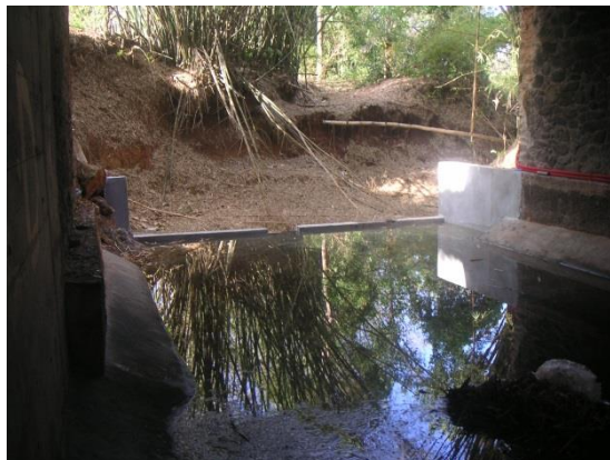
(b) Seuil de de Mro Oua Salim Bé (vue amont)
