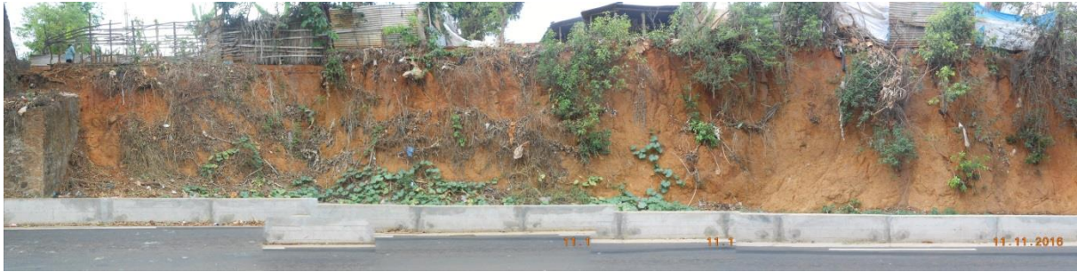
Illustration 30 : Suivi « visuel » des talus de déblai de la RN2
