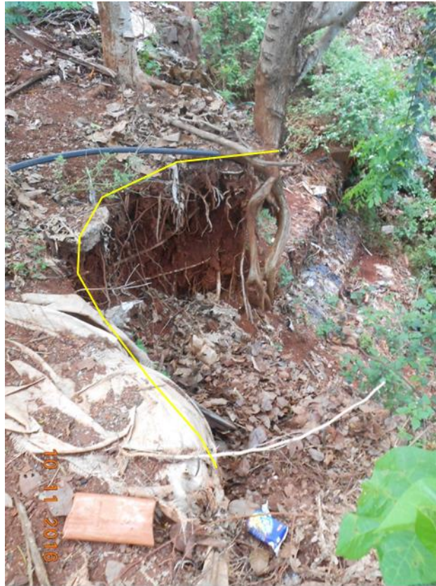
Illustration 20 : Glissement de berges
