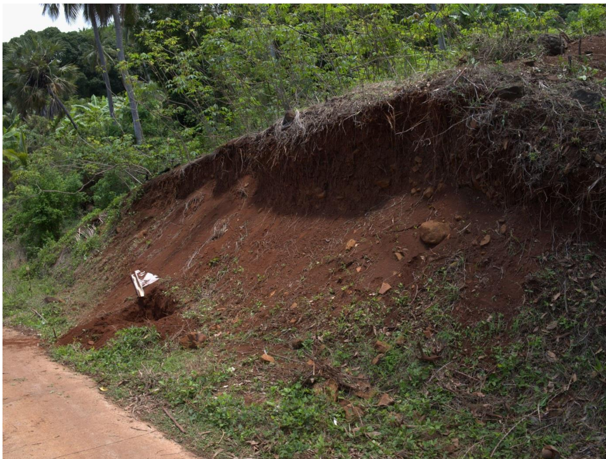
Illustration 28 : Hamjago talus de plate-forme de terrassement en déblai de 8 m de hauteur.
