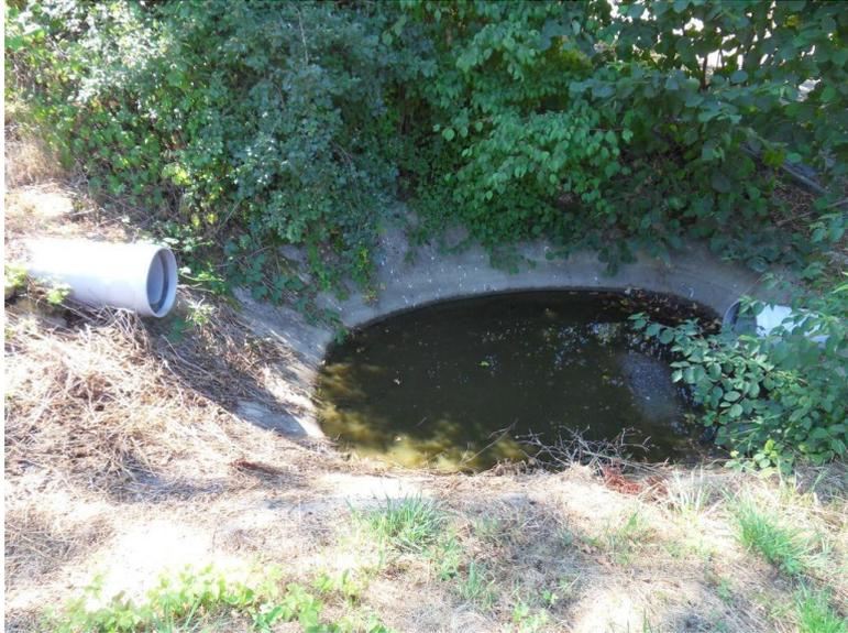
*Illustration 67 : Mare de rétention aval avec fond bétonné*
