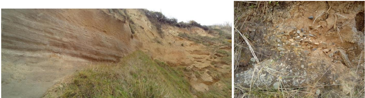
Illustration 11 : Photographie de gauche – Dépôts de pente lités pentés de 5 à 10° vers la mer, contenant des éléments sub arrondis ; Photographie de droite – Détail dans la falaise soit ces galets appartiennent à la base des dépôts de pente soit ils correspondent à une paléo plage et ne sont que plaqués.
