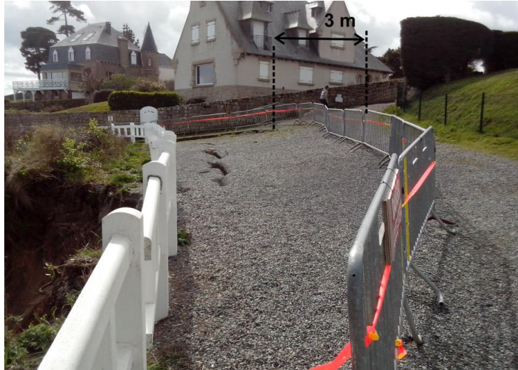
FIG 1 : Photographies de la tête du glissement de terrain et élargissement de 3 m du périmètre de sécurité en tête ;
