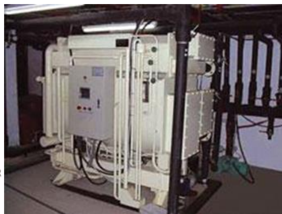
Principe d'une installation de refroidissement par absorption
