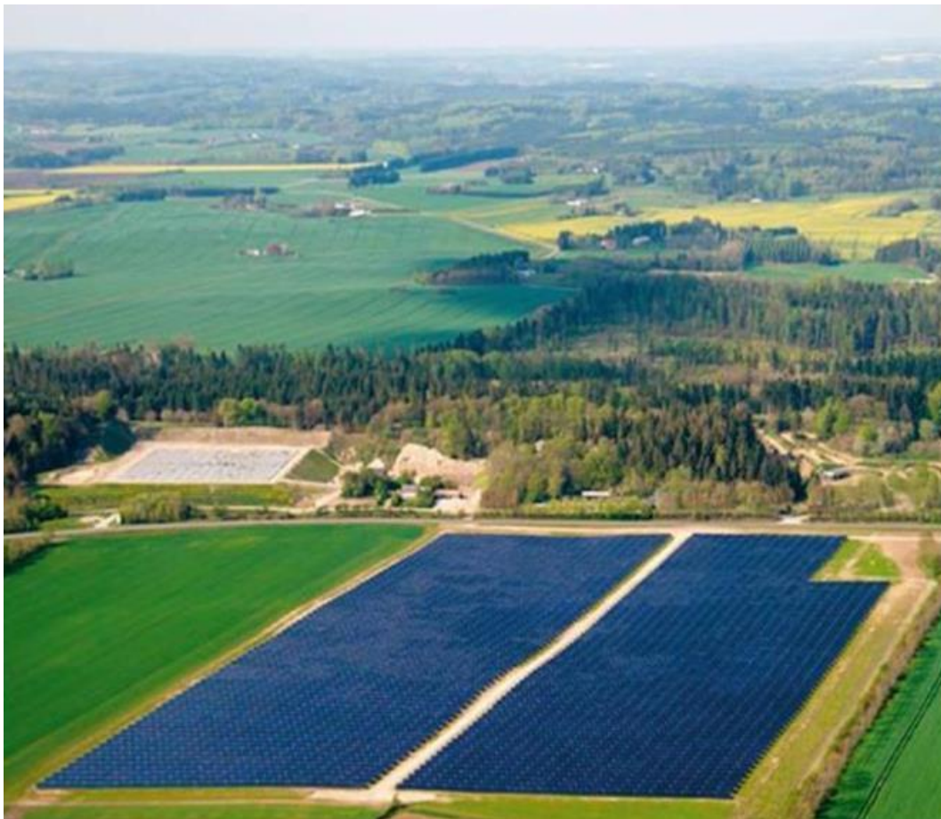
Figure 62 : Vue du champ solaire et du stockage de Dronninglund, Danemark
