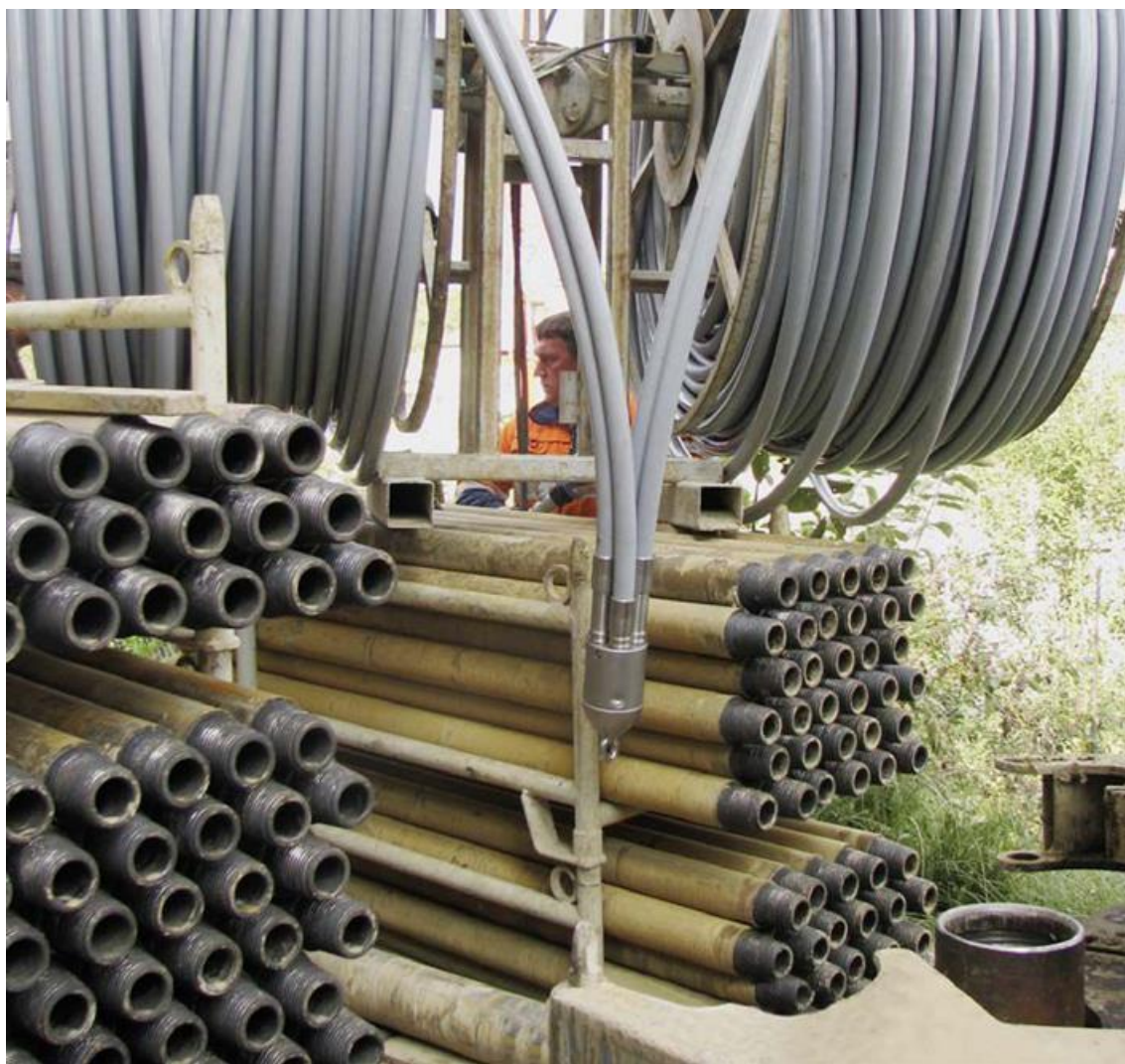
Figure 11 : Photographie d'une sonde géothermique Rehau-HPR avant mise en place
