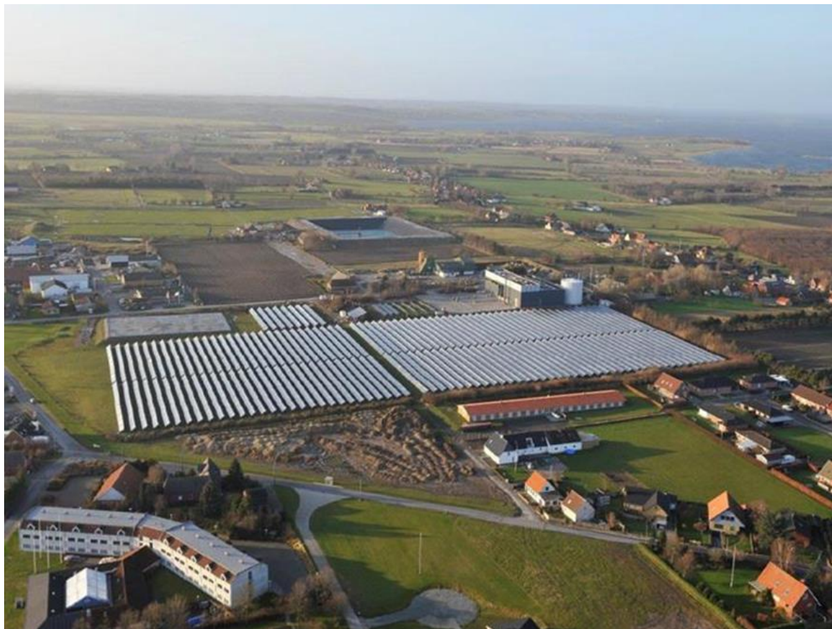
Figure 60 : Vue du champ solaire et du stockage en cours de construction à Marstal, Danemark
