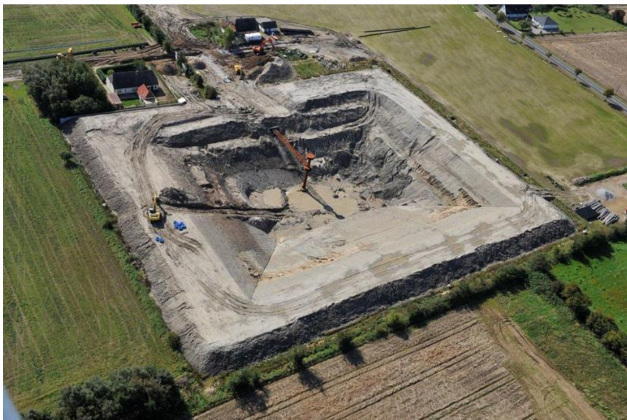
Figure 28 : Photographie du chantier de réalisation du stockage de Marstal, Danemark (2011)
