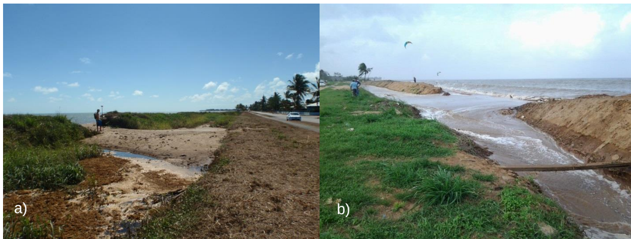
Illustration 8: Photos de la passe de la digue construite contre les risques de submersions Octobre 2015 (a) (BRGM), 9 février 2016(b) (Isabelle Halet)
