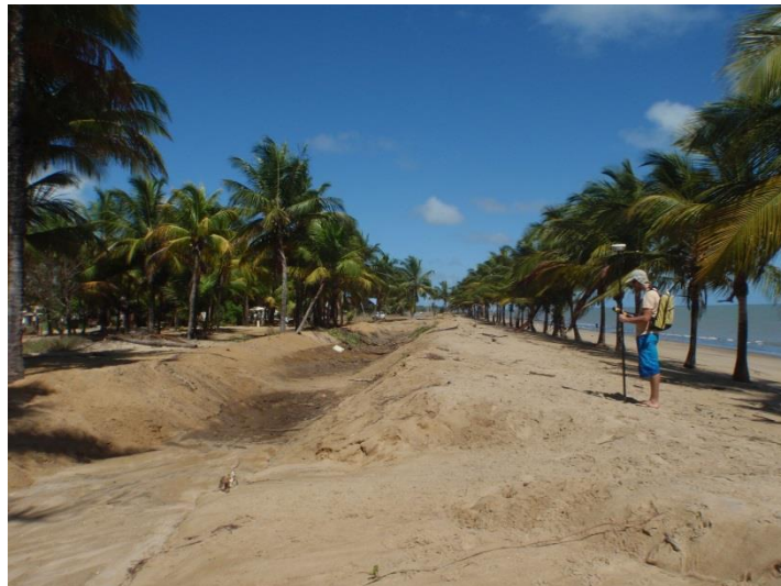
Illustration 2: Digue et chenal d'évacuation des eaux de grandes marées situé à l'Ouest du Village Indien. (BRGM, Octobre 2015)
