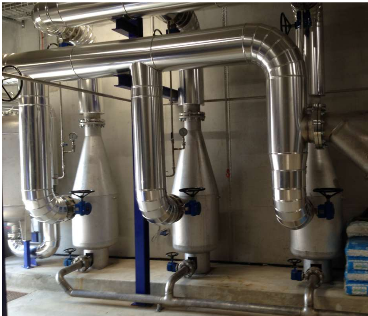
Jeu de trois filtres cycloniques – débit d'eau filtré 350 m 3 /h
