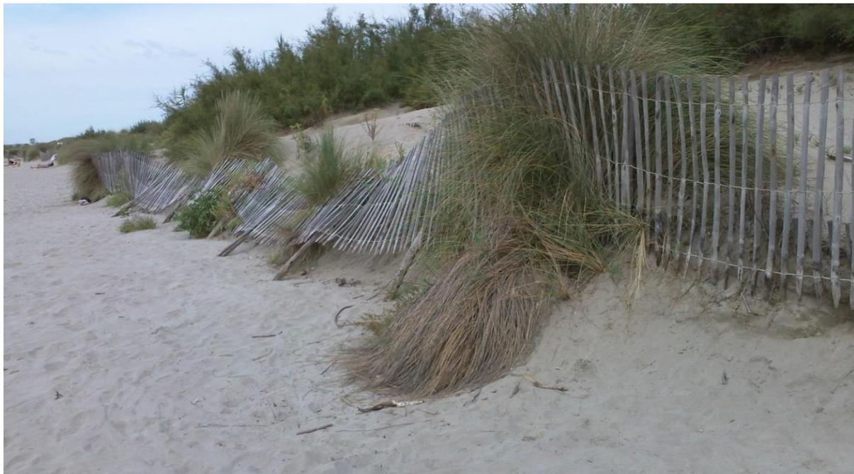
Illustration 30 : Ganivelle dechaussée au niveau d'une petite falaise d'érosion régularisée. Desmazes, 09/15.
