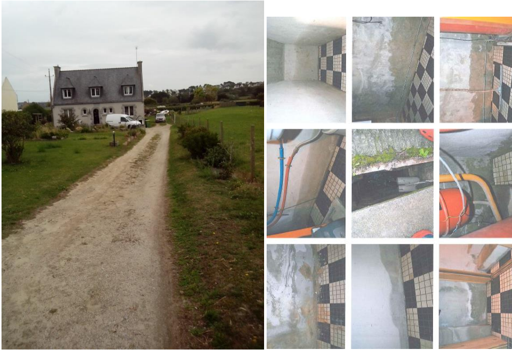
Illustration 10 : Photographie du site 3 (Source BRGM) et des dégâts (source le particulier)
