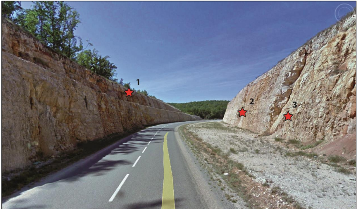
Figure 18 : Vue de la tranchée de route D19 au sein des calcaires oxfordiens, proche de la carrière du Vaylats et localisation des affleurements échantillonnés (cavités n°1, 2 & 3).
