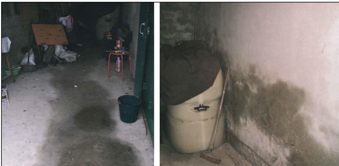
Illustration 8 - Photographies des traces d'humidité dans le garage (clichés transmis par la propriétaire)
