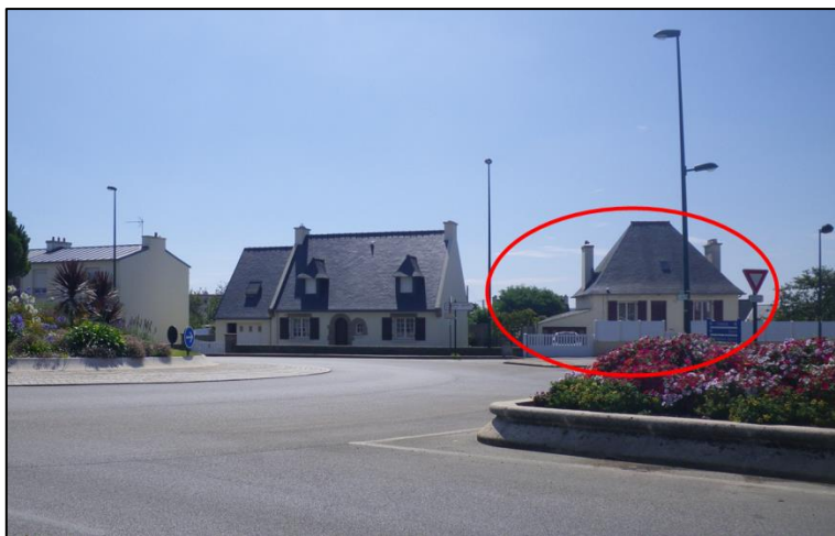
Illustration 7 – Photographie de la maison concernée par les inondations (BRGM, 18/08/2015)
