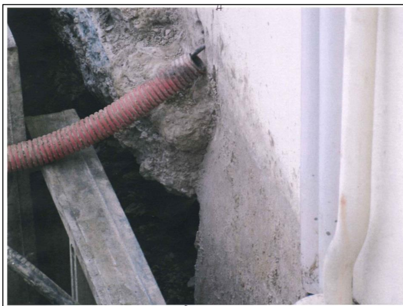
Illustration 9 – Photographie du trou sous la maison provoqué par les inondations (cliché transmis par la propriétaire)
