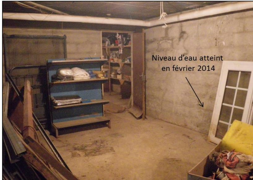
Illustration 10 - Photographie de la cave du 3 Grand Rue et niveau d'eau encore visible sur le mur (BRGM, 18/08/2015)
