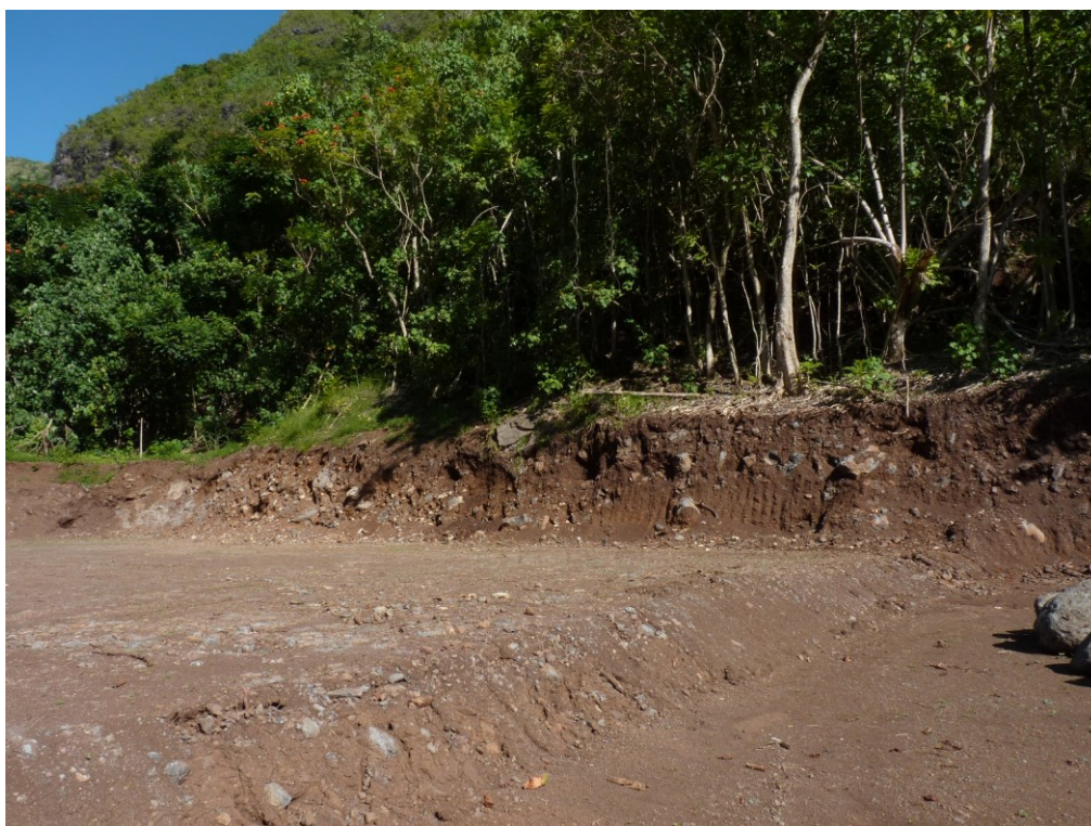
Illustration 4 : Colluvions de pied de pente mis en évidence au pied du versant sud, sur la parcelle CE 185 et CE186
