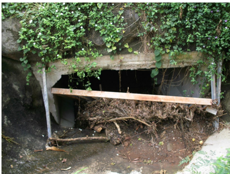
Figure 3 : Vue de l'ouvrage de dérivation le 20/05/2015
