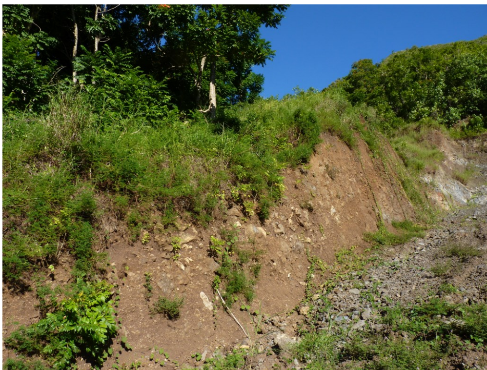
Illustration 7 : Forte épaisseur de colluvions de pied de pente, mise en évidence à la faveur de l'excavation de la parcelle CE 36
