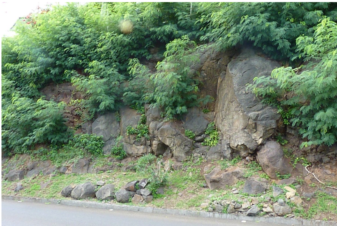
Illustration 4 : Amont de la route. Coulée massive en amont du versant, sur la partie centrale, avec une individualisation de bloc de plus de 10 m 3
