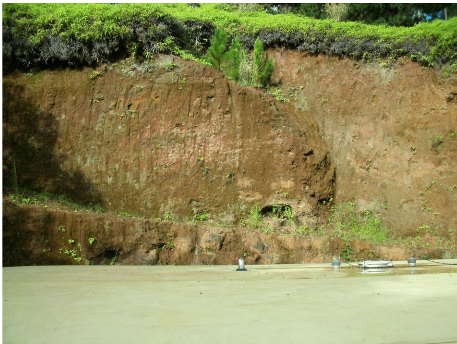
Illustration 8 : Talus le long de la route d'accès au lotissement, constitués de coulées altérées
