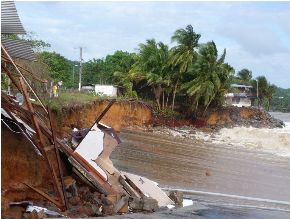
Illustration 1 : Erosion au niveau de l'établissement « rhumerie beach » dans l'anse de Rémire en janvier 2013 (BRGM)
