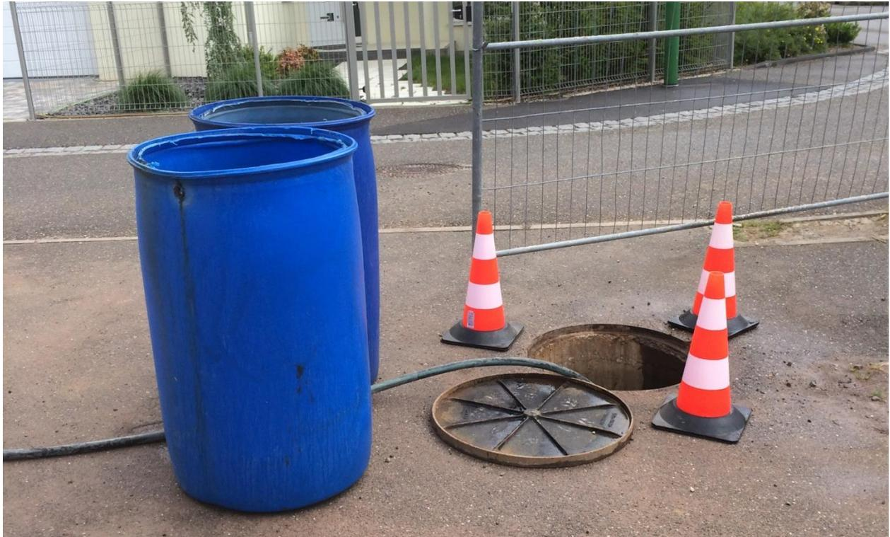
Figure 21 : Fûts permettant l'estimation du volume de glycol présent dans les sondes et évacuation dans le système des eaux usées.
