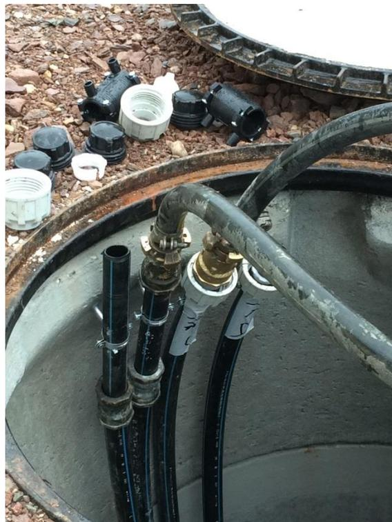
Figure 19 : Raccordement des tuyaux de purge sur la sonde S7.
