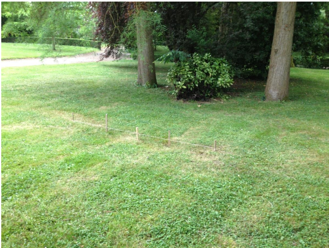
Illustration 8 : Mouvement de terrain détecté à l'aval du puits
