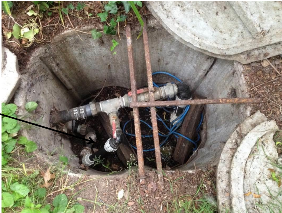
Illustration 3 : Photos de l'ouvrage et de la fosse technique située à proximité
