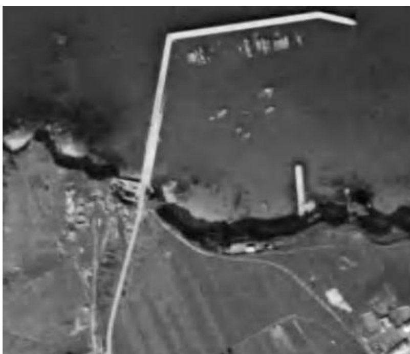
Illustration 8 : Extrait d'une image aérienne IGN d'une campagne de 1965 ( www.geoportail.fr ) ; il est possible de constater que l'aménagement de la plateforme du port n'existait pas et que des matériaux ont été extraits de la falaise et que la maisonnette impliquée était déjà présente.
