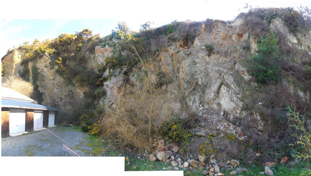
Illustration 7 – Panoramas des éboulements, en haut : celui ayant impacté un ouvrage, en bas celui sans impact sur ouvrage
