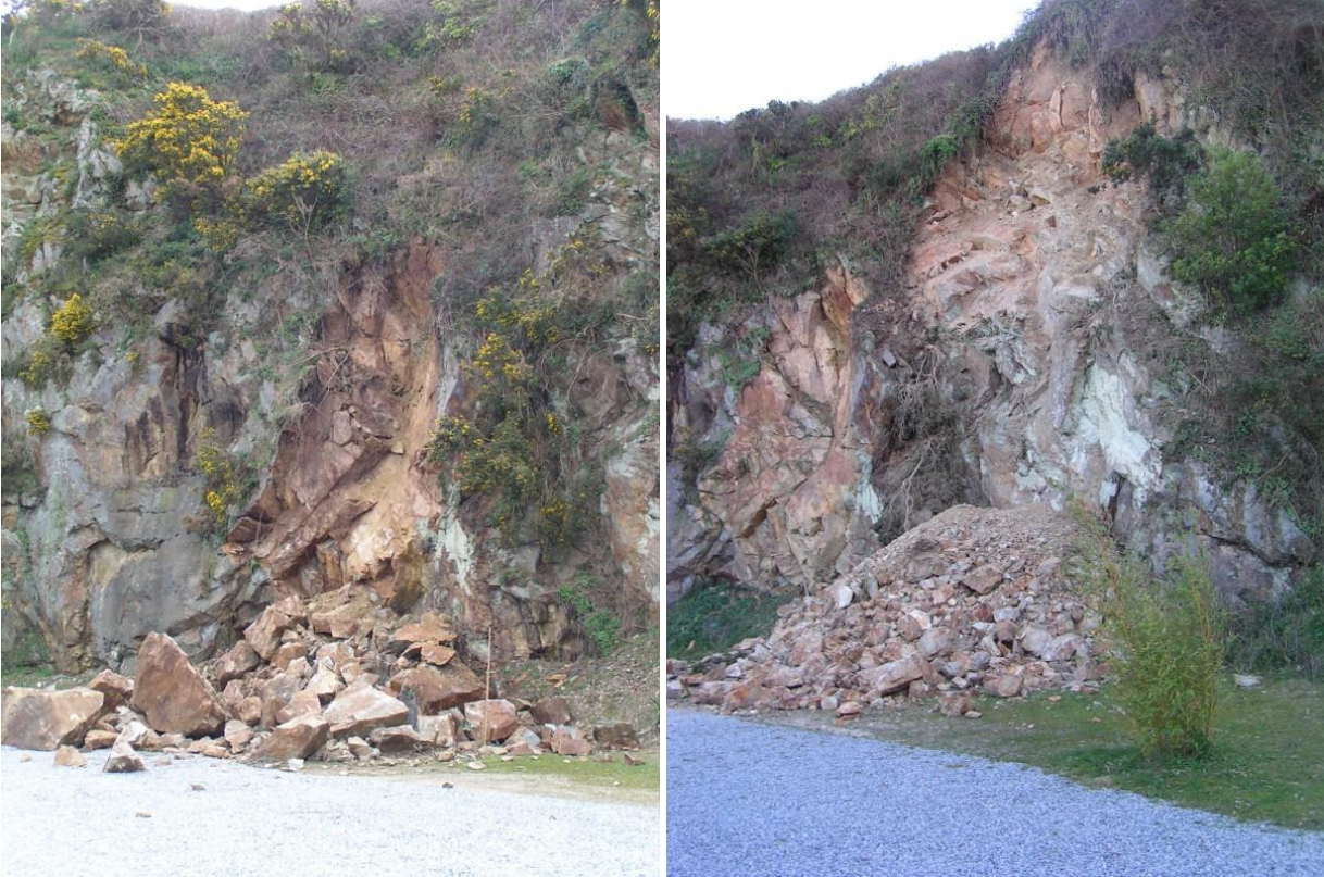
Illustration 5 : Photographies fournies des évènements ayant affecté le front de taille de la parcelle ZH 584a, Le-Palais (56), à gauche en 2009, à droite en 2010 et cicatrice encore visible de 2009 (sources : les propriétaires).
