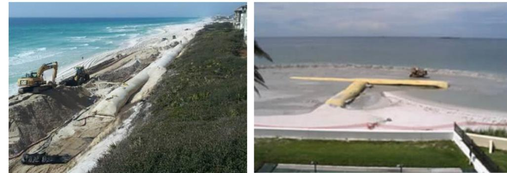
Illustration 14 - Exemple de structures en géotextiles longitudinal en pied de dune (à gauche) ou en épi en T (à droite).
