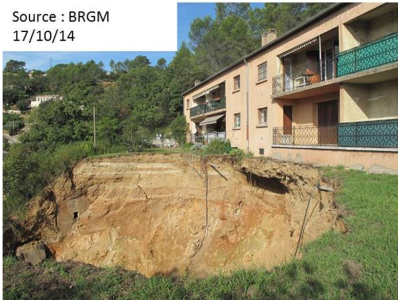
Illustration 5 : Evolution de l’effondrement entre le 9 octobre et le 17 octobre 2014 (Sources : Var Matin, Ville du Luc et BRGM)
