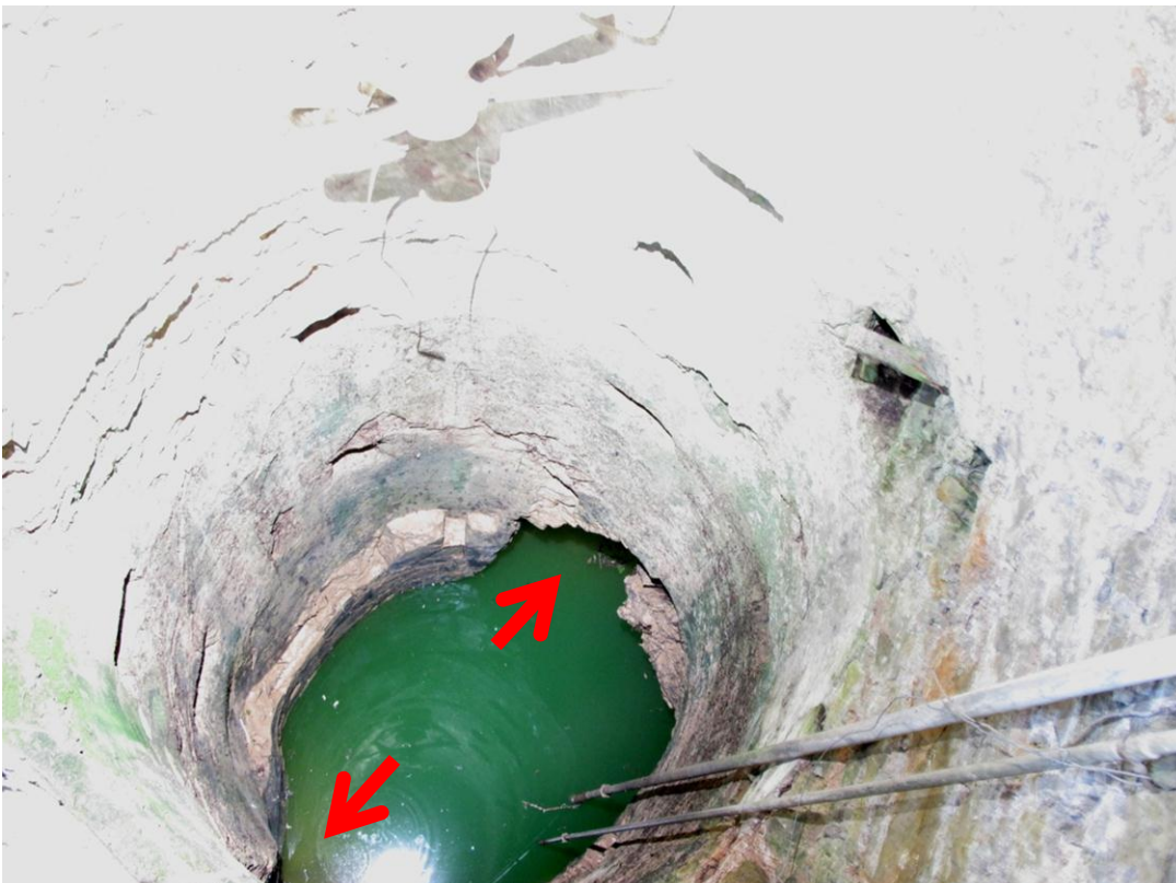
Illustration 10 : Vue dans le puits avec les départs de deux galeries bien visibles
