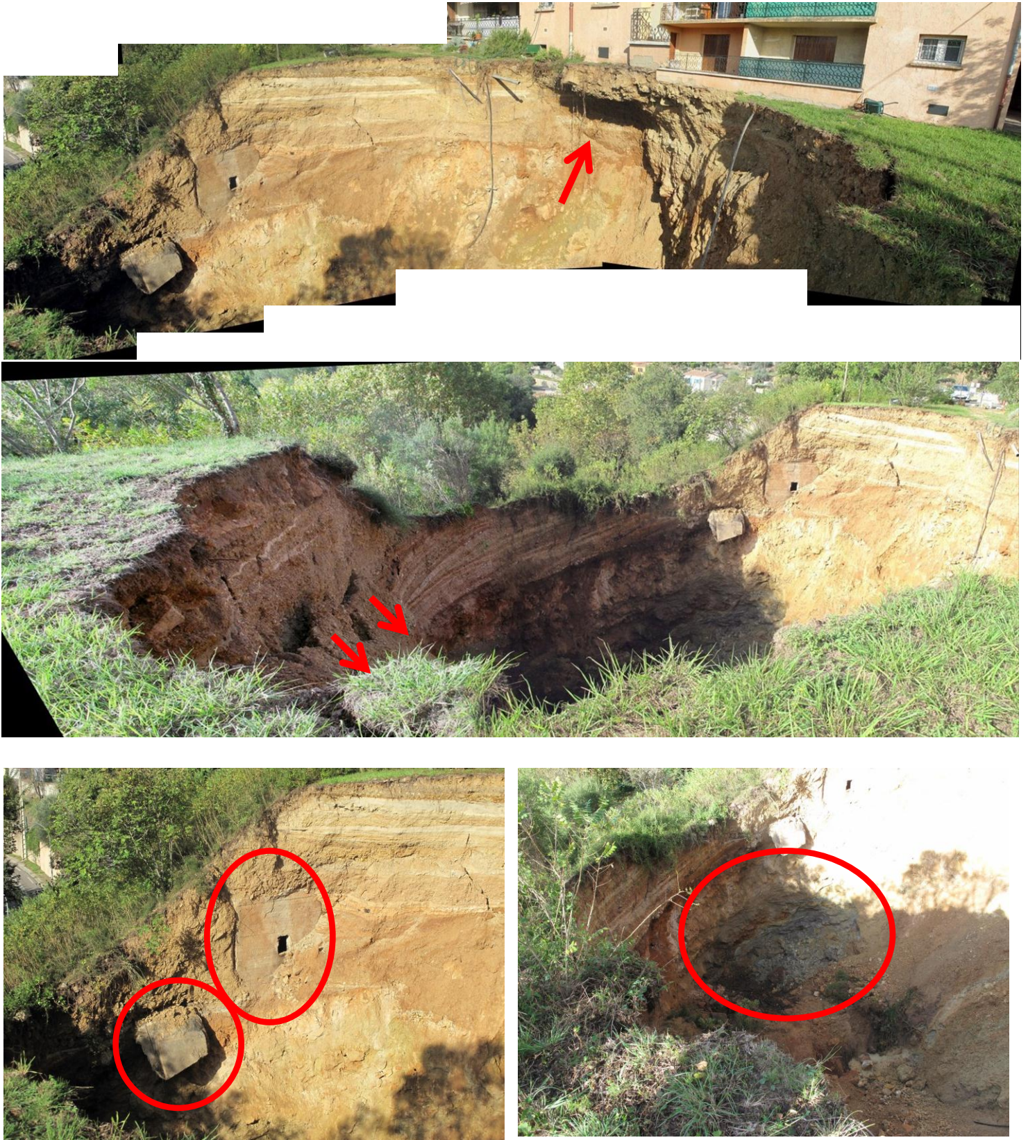
Illustration 7 : Différentes vues de l’effondrement (1- vue vers le nord et vers le sous-cavage formé sous le bâtiment B ; 2- vue vers le sud au-dessus de la RD433 et écailles visibles prêtes à tomber ; 3- Zoom sur les vestiges en béton de l’époque de l’exploitation du gypse ; 4- vue vers le fond du fontis en eau au moment de la visite et sur les marnes grises et noirâtres).
