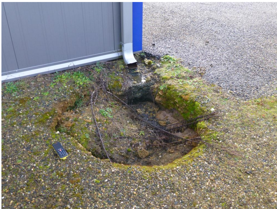
Figure 65 : Fontis de petite taille au droit d'une gouttière (Roquefort, département des Landes)
