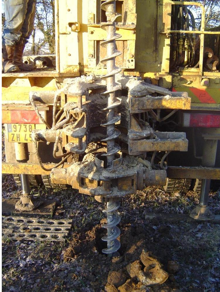
*Illustration 25 - Tige hélicoïdale en diamètre 152 mm et remontée des déblais*
