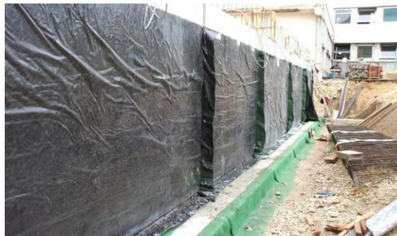
Figure 6 : Exemple de mise en œuvre d'une membrane le long d'une paroi moulée verticale (Source : Documentation technique et commerciale, société CETCO).
