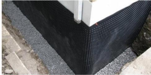
Figure 8 : Cuvelage des fondations d'un bâtiment.
