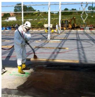
Figure 5 : Photographie représentant l'application d'une membrane en spray.
