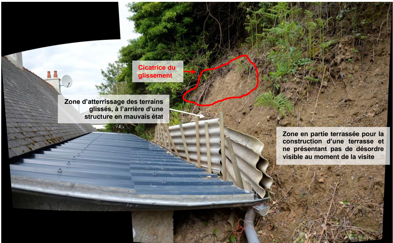
Figure 18 : Site H, RD 786 – vue du glissement
