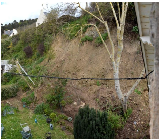
Vue du glissement depuis le 1 er étage de la maison
