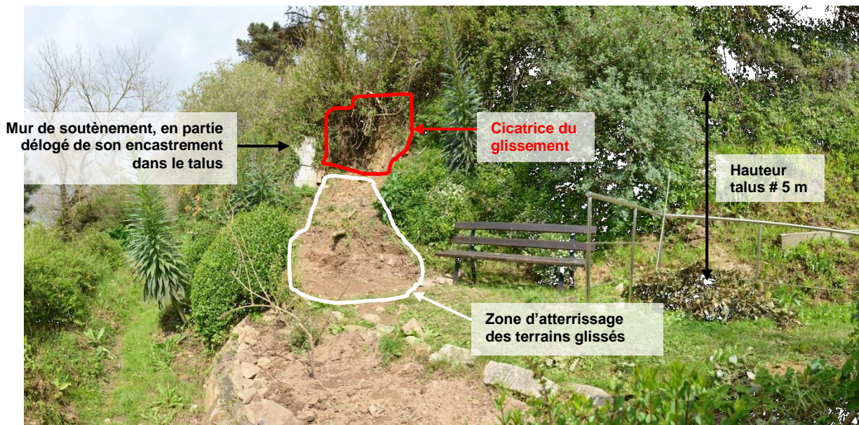
Figure 14 : Site F, au-dessus du 15 route d'Arvor (RD786) – vue du glissement
