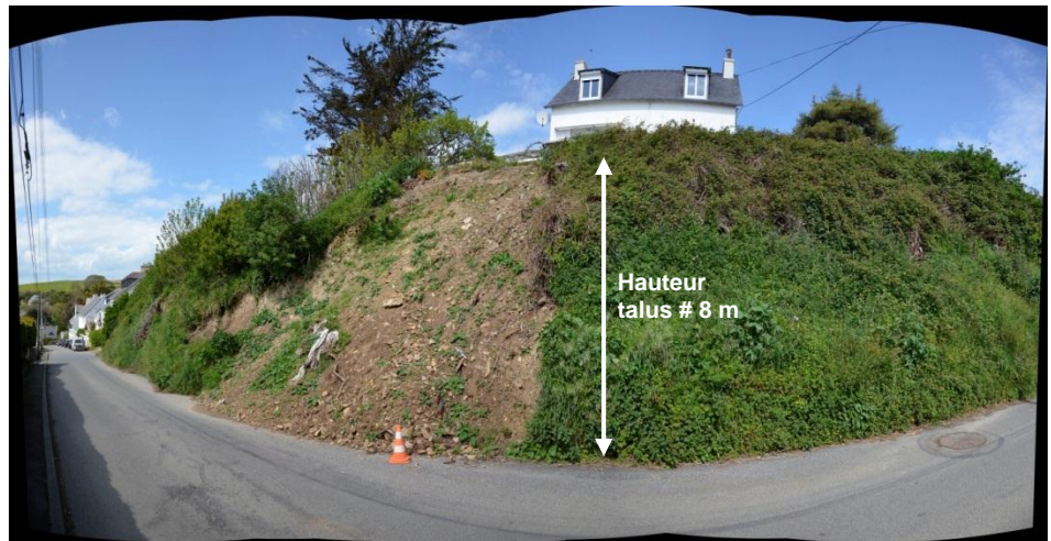
Glissement A2 (photographie panoramique partiellement déformée)
