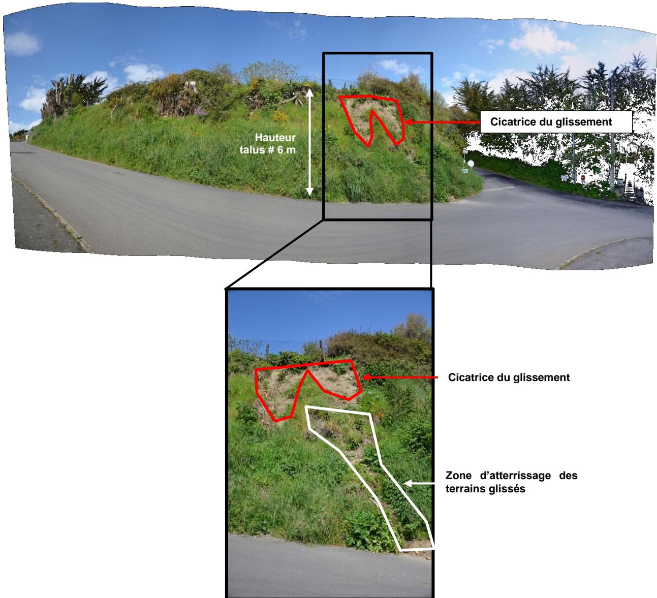
Figure 9 : Site B, route de Toul ar Vilin – vues du glissement
