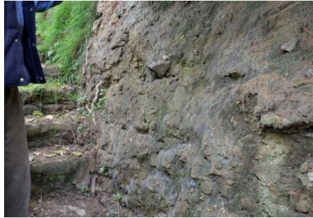
Figure 16 : Site G, 25 route d'Arvor (RD786) – vue de détail du talus
