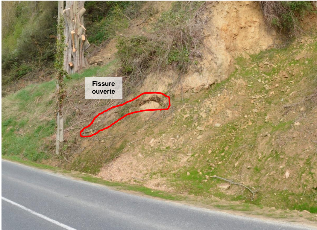
Figure 13 : Site E, RD786 – vue de détail du bas du glissement E2
