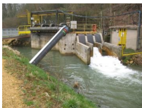
Galerie des Eaux à Knutange
