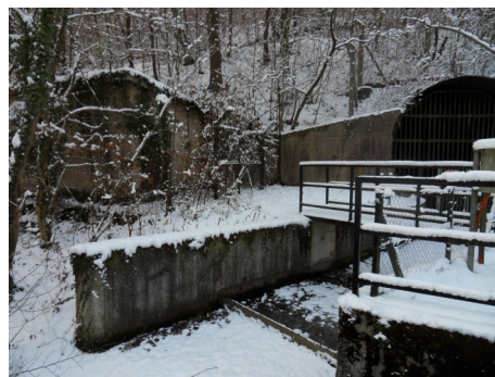
Exutoire de la galerie de Bois d'Avril
