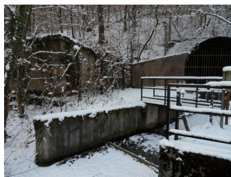
Exutoire de la galerie de Bois d'Avril
