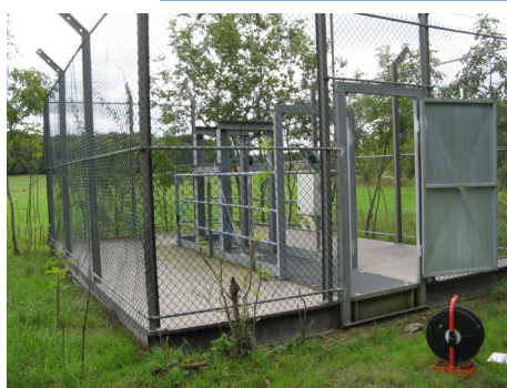
Puits Cheminée Sud à Boulange
