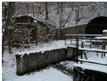
Exutoire de la galerie de Bois d'Avril
