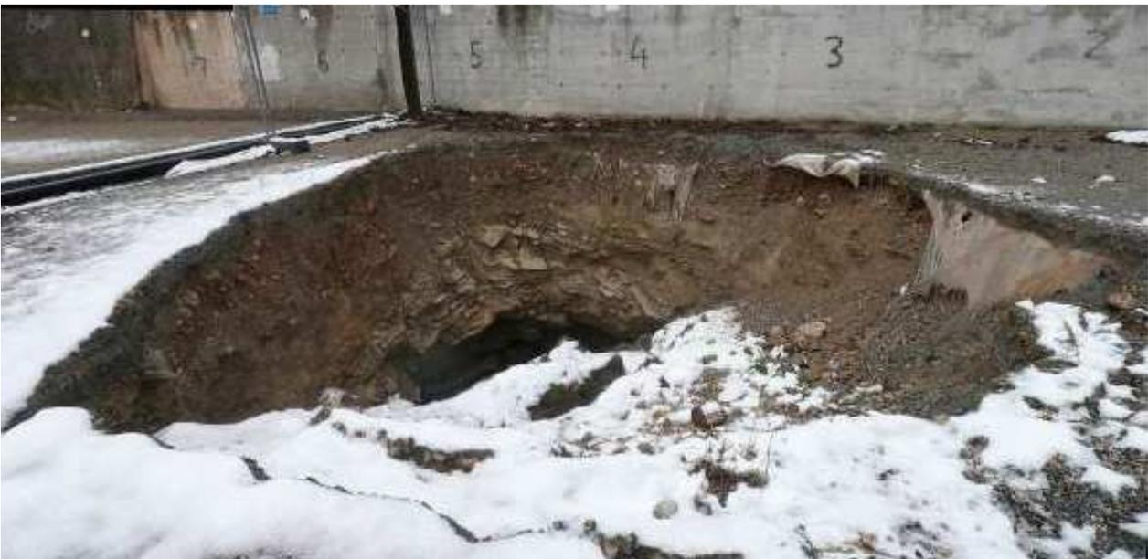
*Illustration 33 : Photo du fontis prise en février 2013. Dimensions observées : 5 à 6 m de diamètre, profondeur visible depuis la surface : au moins 4 m.*
