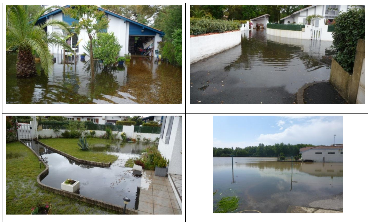
Figure 7 – Inondations de plusieurs habitations par remontée de nappe à Tarnos (40) en Aquitaine en juin 2013 (clichés pris par les propriétaires)
